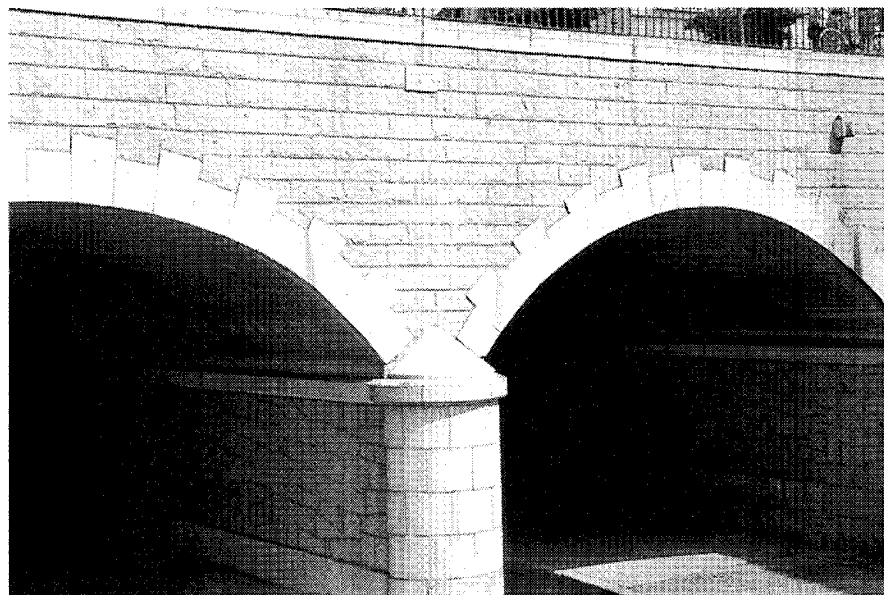
Puente de 1873 sobre el río Guadarrama en la calle Real. Fot. José Rodríguez Ablanedo.
