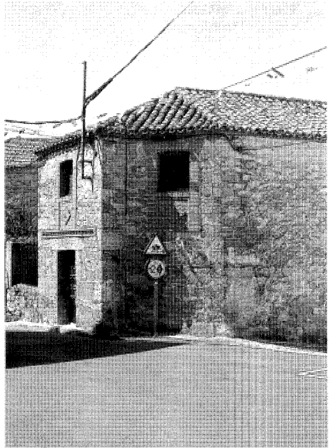
Vivienda singular en chaflán de la plaza de la Constitución. Fot. José Rodríguez Ablanedo.
