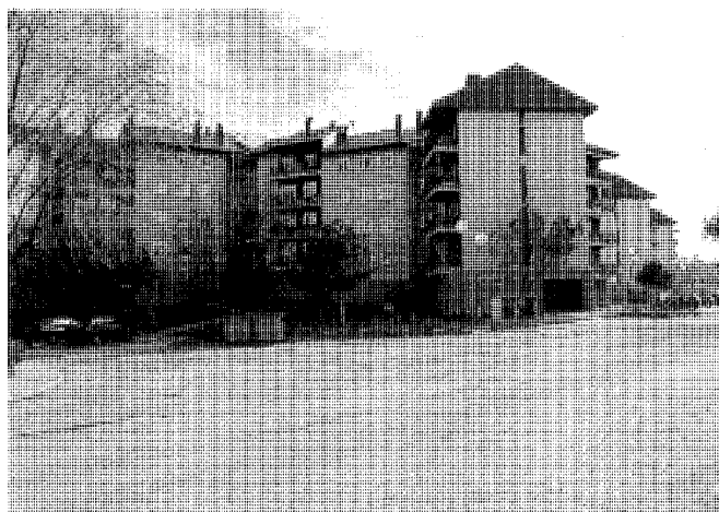
Bloque residencial tipo de la Colonia Suertes Nuevas (años setenta-ochenta). Fot. José Rodríguez Ablanedo.
