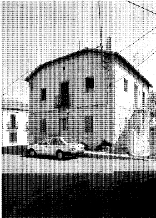
Casón con escalera exterior de acceso a la planta alta en la antigua carretera de Moralzarzal c/v calle del Santo. Fot. José Rodríguez Ablanedo.
