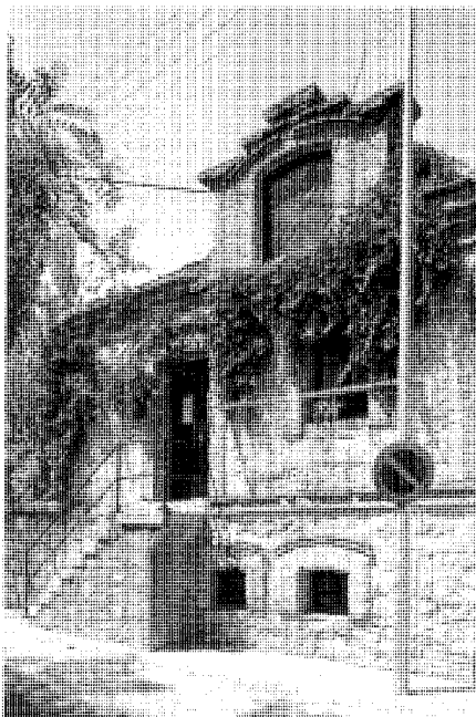
Conjunto neomudéjar de vivienda principal y casa de guarda en el ensanche interior al núcleo. Fot. José Rodríguez Ablanedo.
