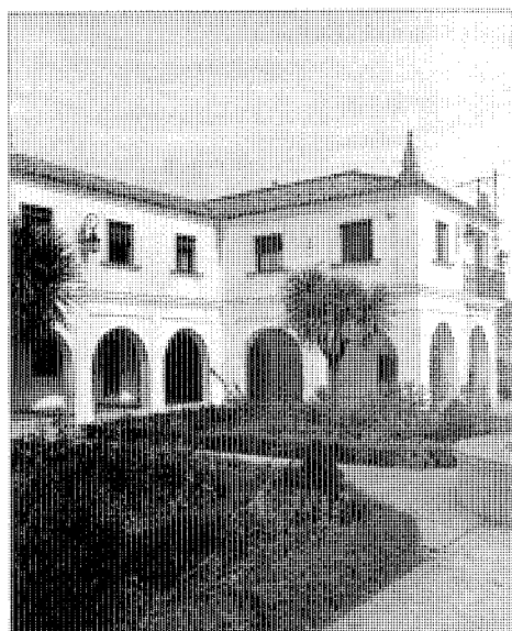
Fachada lateral interior. Estado actual.
