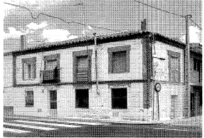
Vivienda en la avda. del Generalísimo nº 63. Fot. Actividades y Servicios Fotográficos, S.A.
