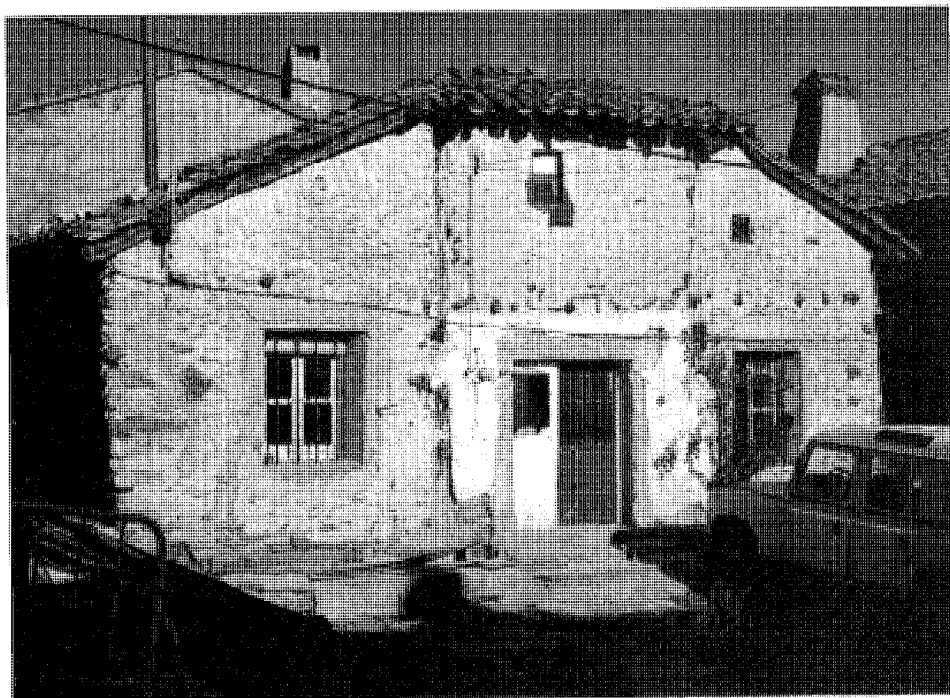
Vivienda en la calle de San Antonio
