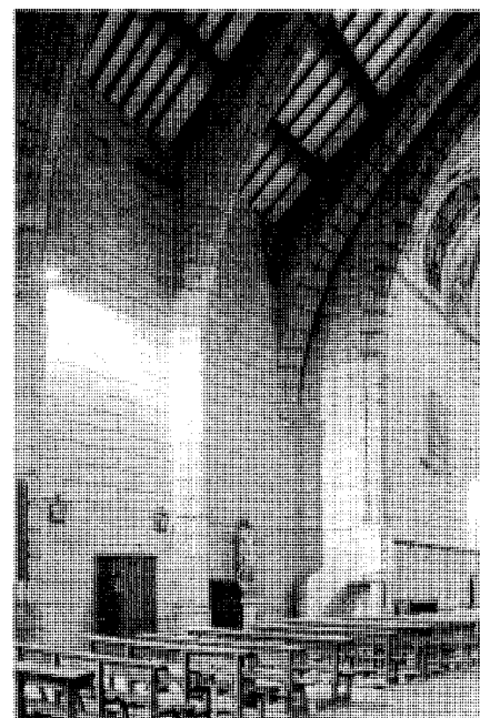
Detalle de los arcos diafragmáticos. Fot. Actividades y Servicios Fotográficos, S.A.
