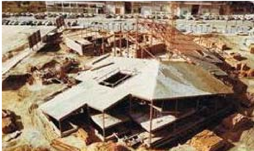
L. Cubillo: Parroquia de San Fernando en construcción, Madrid, 1971-1972
