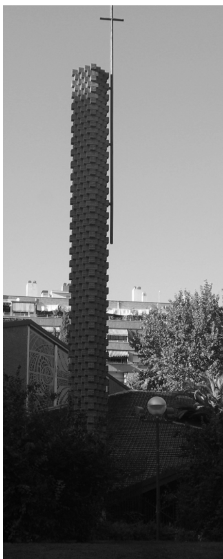
L. Cubillo: Torre de la iglesia de San Fernando, Madrid, 1970.
