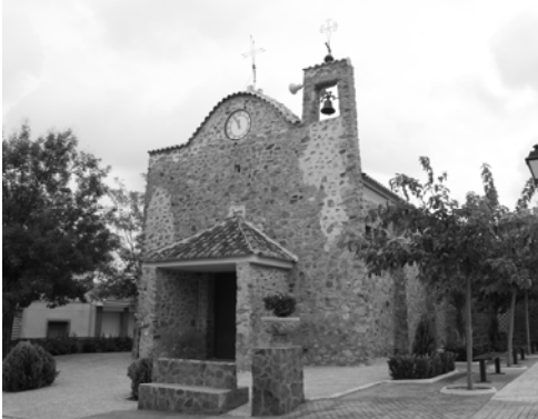
Iglesia de Pozo de la Serna. Estado actual
