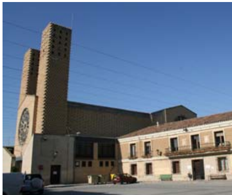
L. Cubillo: Iglesia de Cadreita, Navarra, 1956.
