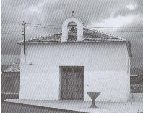
Iglesia de El Trincheto. Estado actual
