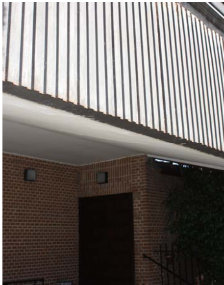
L. Cubillo: frente de forjado revestido de chapa Pegaso en la parroquia de Serranillos del Valle (Madrid), 1971
