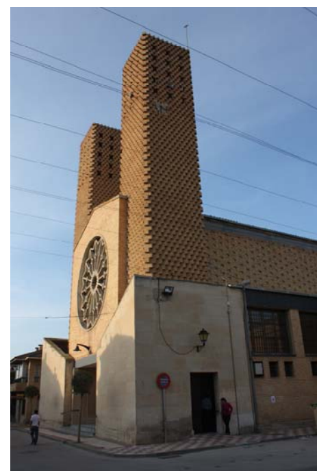
L. Cubillo: Resolución del encuentro de fachadas en la iglesia de Cadreita, Navarra.
