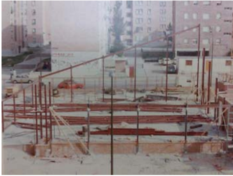
L. Cubillo: Construcción de la estructura de la parroquia de Santa María Buen Aire, Madrid, 1981-82.
