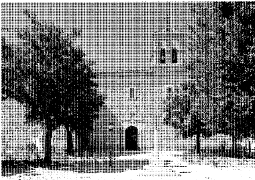
Fachada de la iglesia a la plaza del Convento. Actividades y Servicios Fotográficos, S.A., 2001.
