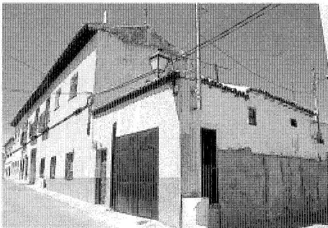
Vista lateral desde el callejón del Indiano. Actividades y Servicios Fotográficos, S.A., 2001.
