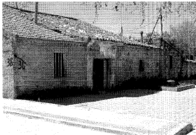
Conjunto rural en los bordes de la calle Real. Fot. José Rodríguez Ablanedo.
