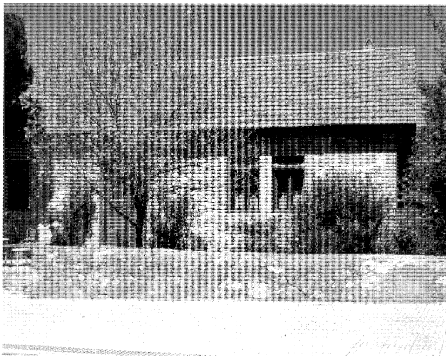
Calle Real n ° 39. Fot. José Rodríguez Ablanedo.
