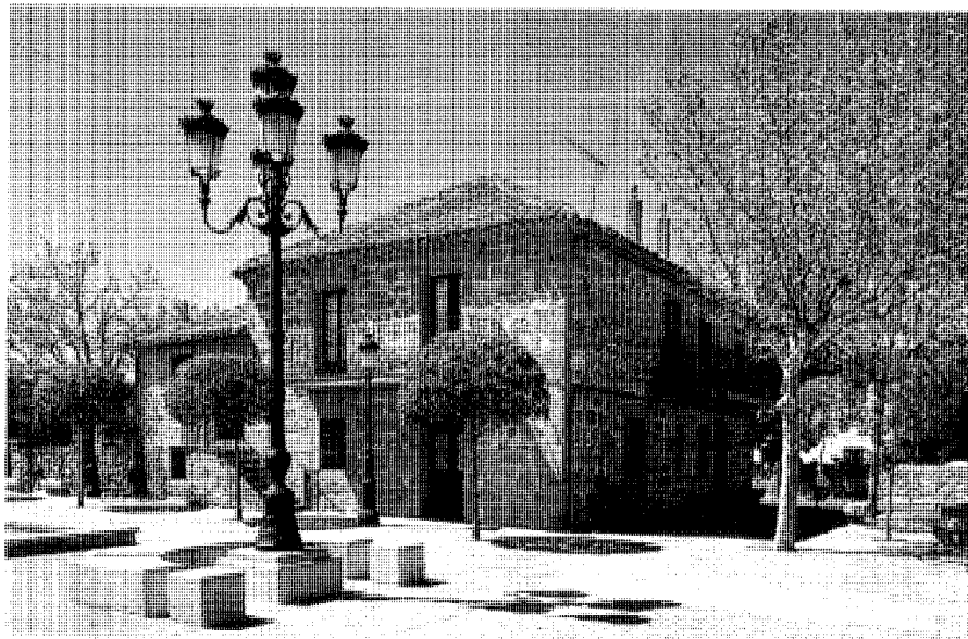
Ejemplo urbano-rural. Plaza de la Constitución nº 2. Fot. José Rodríguez Ablanedo.
