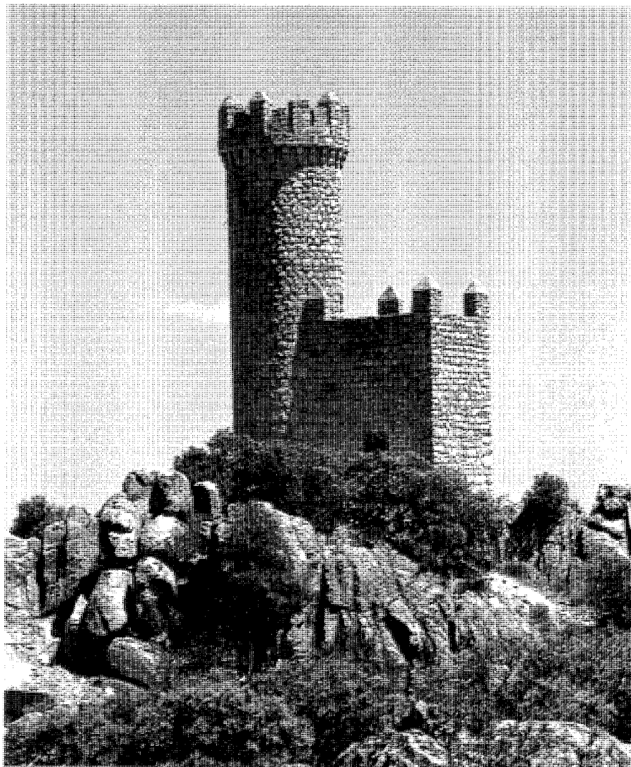
Vista principal. Fot: José Rodríguez Ablanedo
