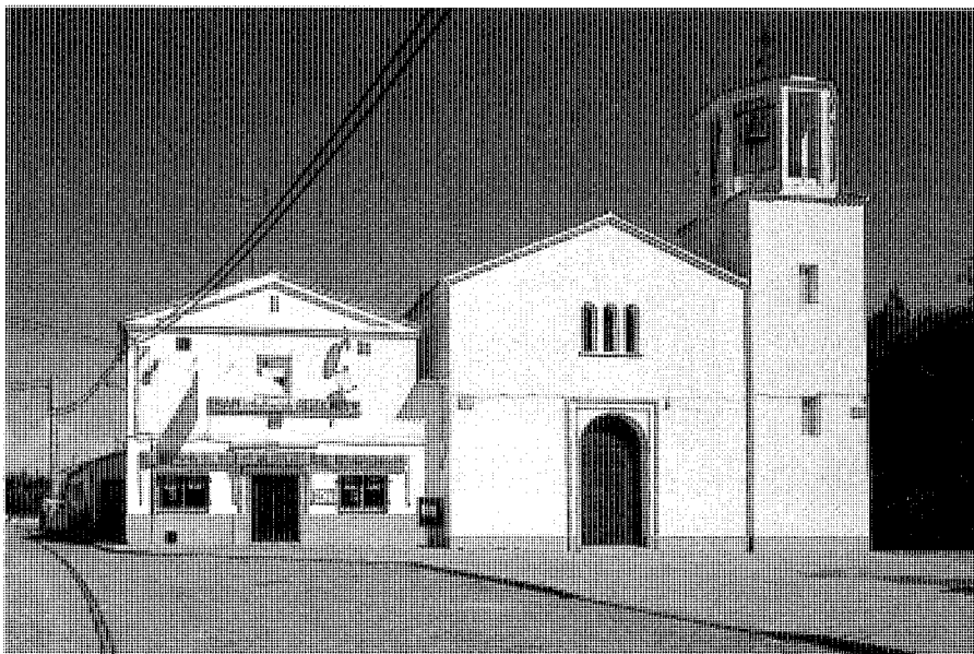
Iglesia de Santa María de Arbuel. Estado actual.
