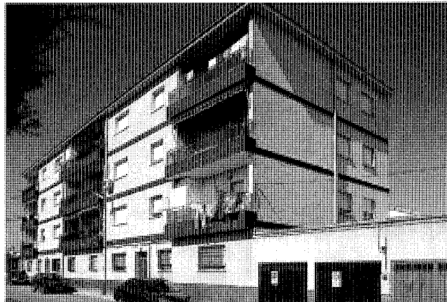
Bloque de viviendas en el casco antiguo. Impacto negativo de los años 60
