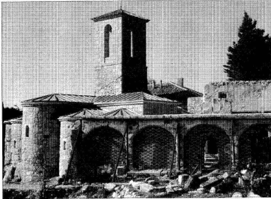
Arquería recuperada en la última rehabilitación, posiblemente perteneciente al primitivo claustro conventual
