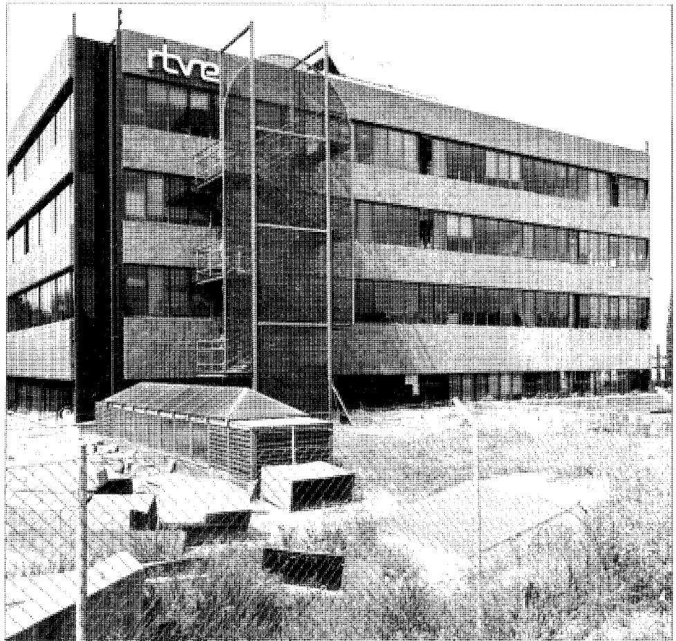
Vista del edificio.
