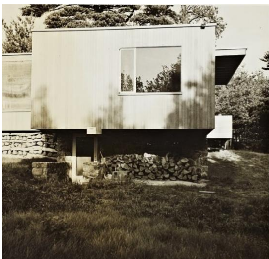
[Fig 28] Chamberlain cottage. Marcel Breuer, 1940. Fotografía del autor. Marcel Breuer Digital Archive, universidad de Syracuse (NY). ID 13743-001
