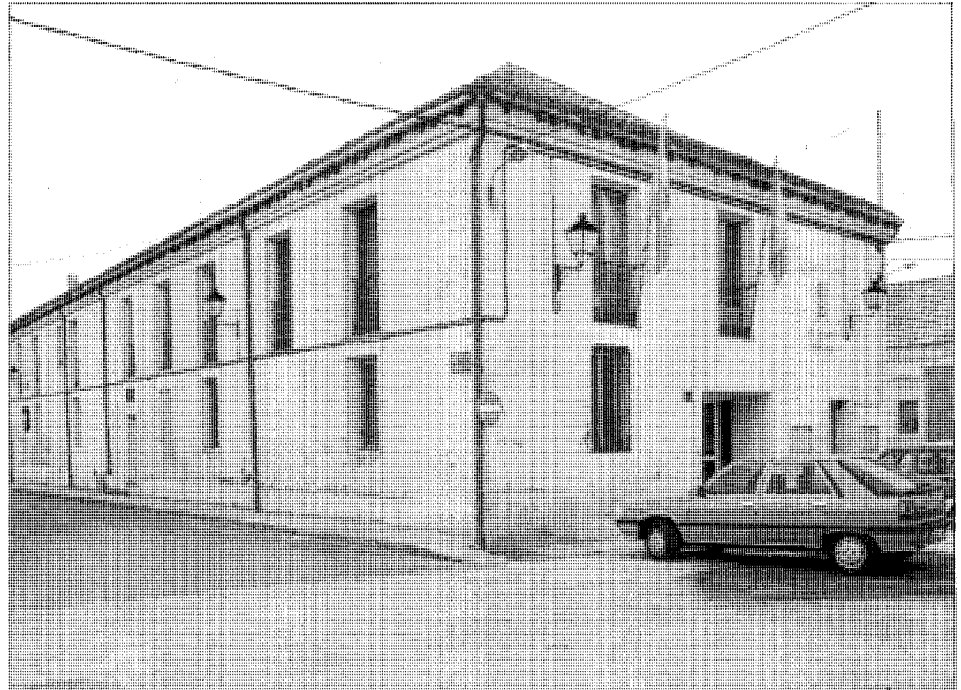
Vista general del edificio
