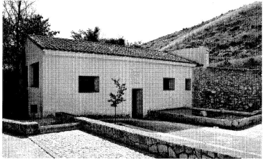
Vista del estado actual del antiguo edificio de bombeo de agua.
