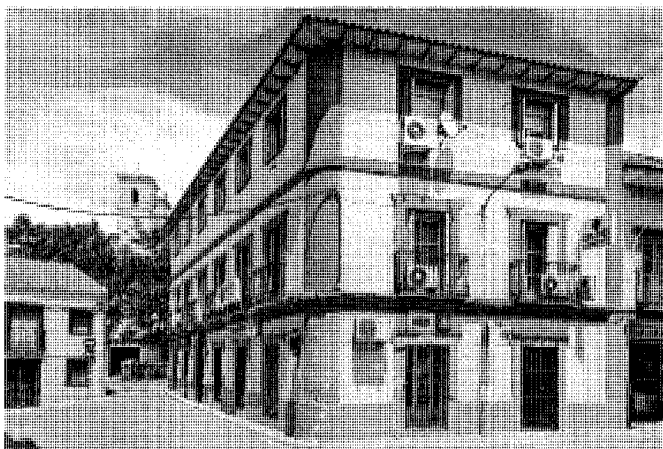
Vivienda en la calle Real, 2, con vuelta a la calle Morata.
