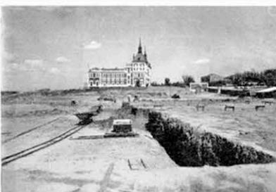
1. Comienzo de las obras. 10 de julio de 1933.
