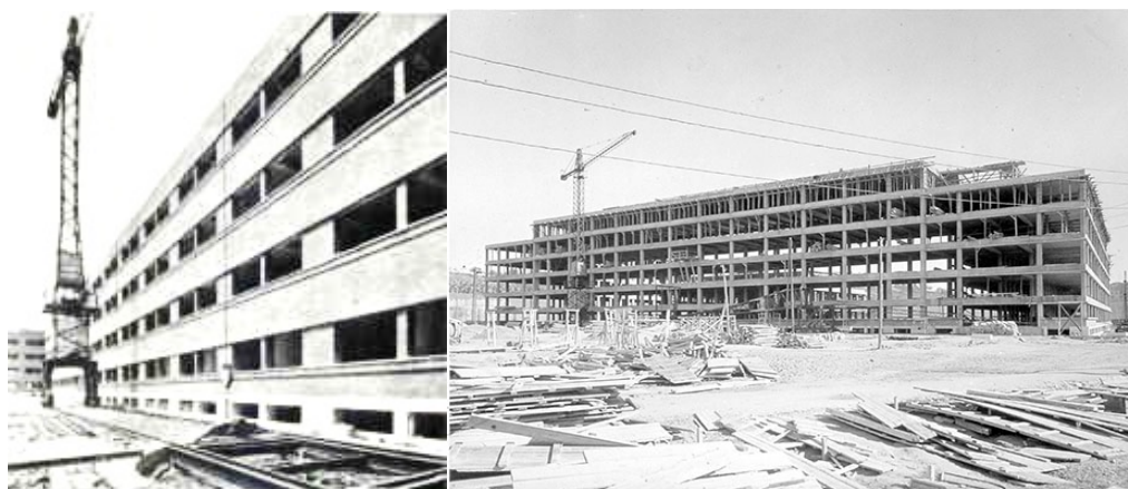
Fig. 46. Fotografías de la facultad de Ciencias tras su reconstrucción. 1943. La CUM. Vol. II. COAM
