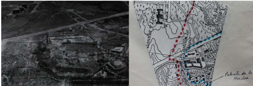
Fig.21. Foto y plano de zona de trinchera en zona del Palacete . AGHEA
