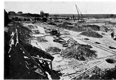
3. Iniciación de las obras en 16 julio 1932.
