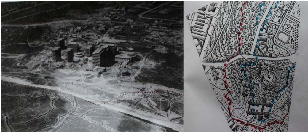
Fig.22. Foto y plano de zona de trinchera en zona de El Clínico. AGHEA
