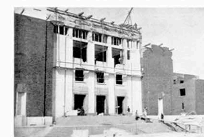
17. Reconstrucción del pórtico de ingreso en 27 de marzo de 1934.
