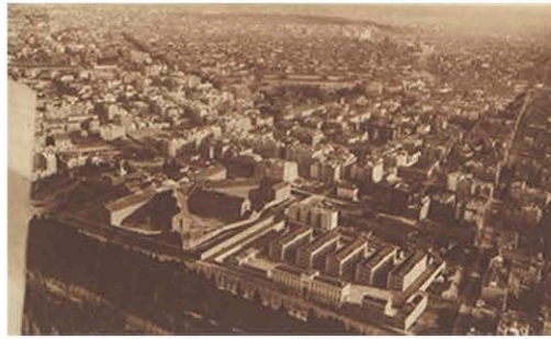
Cárcel Modelo con su abanico de naves gemelas. Nuevo cuartel de Ingenieros en la calle Moret en el barrio de Arguelles.
