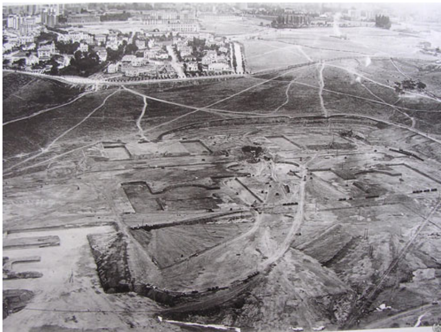
Fig.42. Imágenes del replanteo y vaciado de las obras de Medicina y Farmacia sobre 1930 Fondos bibliográficos de la ETSAM
