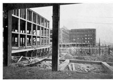
10. La primera parte, desde la estructura de la segunda, en 13 noviembre 1932.
