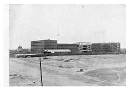
18. Estructura de las obras en 17 septiembre 1933.
