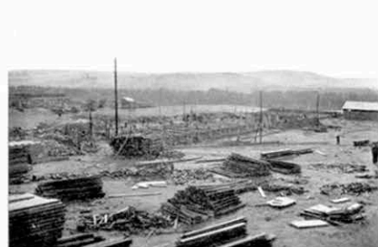
3. Estado de la estructura en 4 de octubre de 1933.
