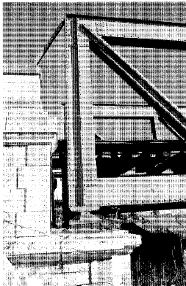
Puente sobre el Tajo. Detalle de apoyo sobre estribo. Foto Actividades y Servicios Fotográficos, 2003.
