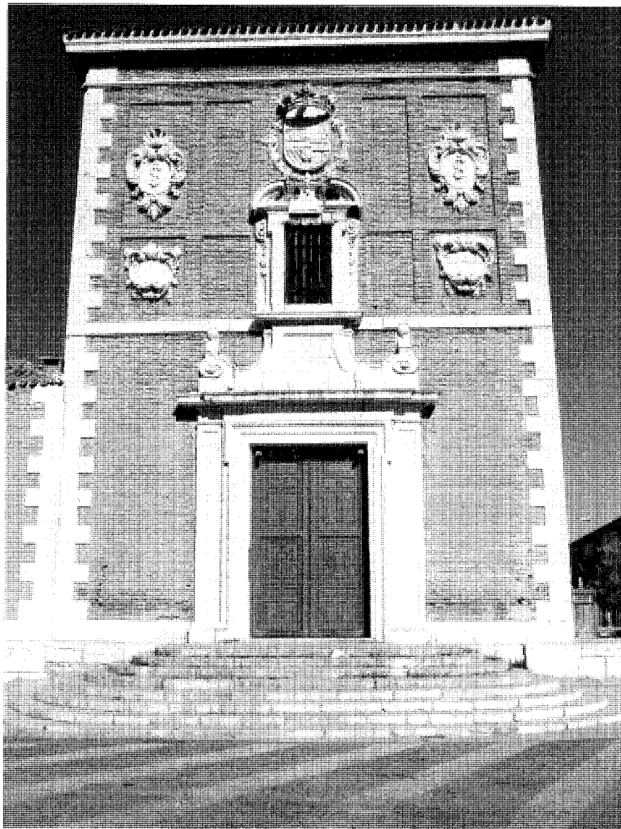
Fachada principal. Foto Vicente Patón.
