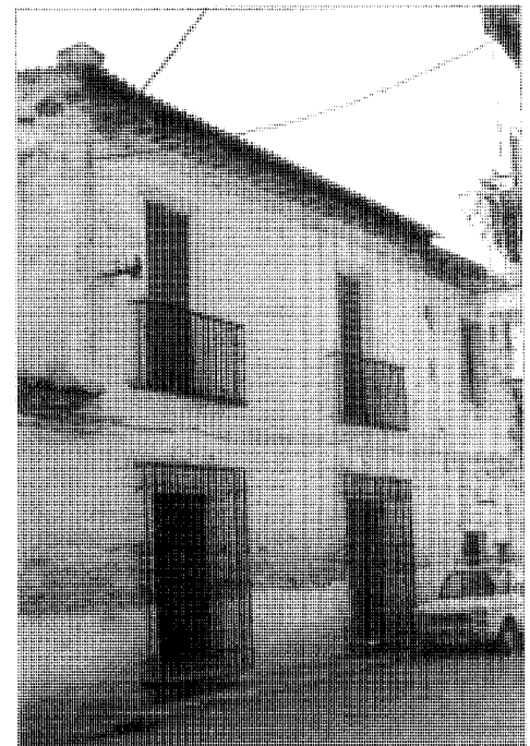
Fachada. Calle Nueva.
