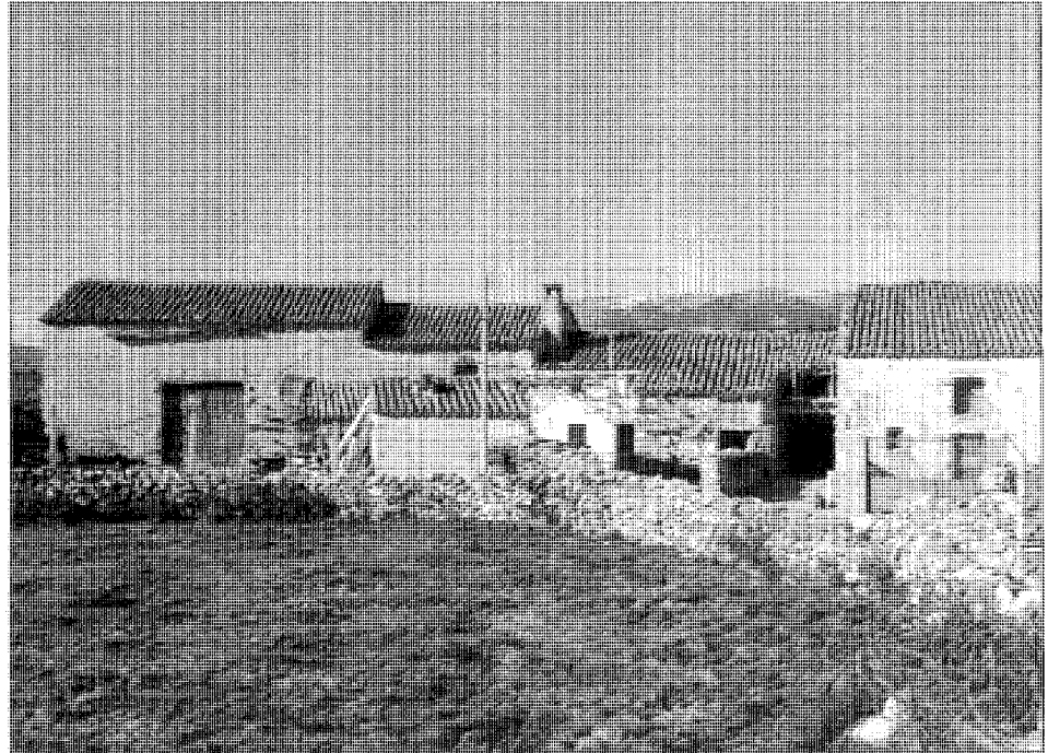
Gandullas. Conjunto mixto en la calle del Sol
