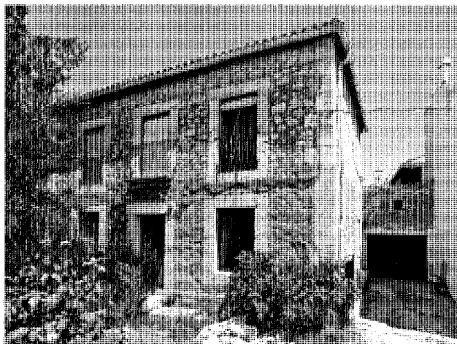
Vivienda en la Glorieta de los Caídos 3.
