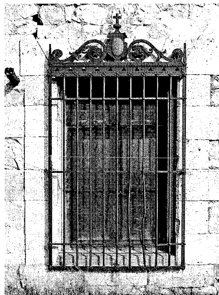
Detalle de hueco de fachada.
