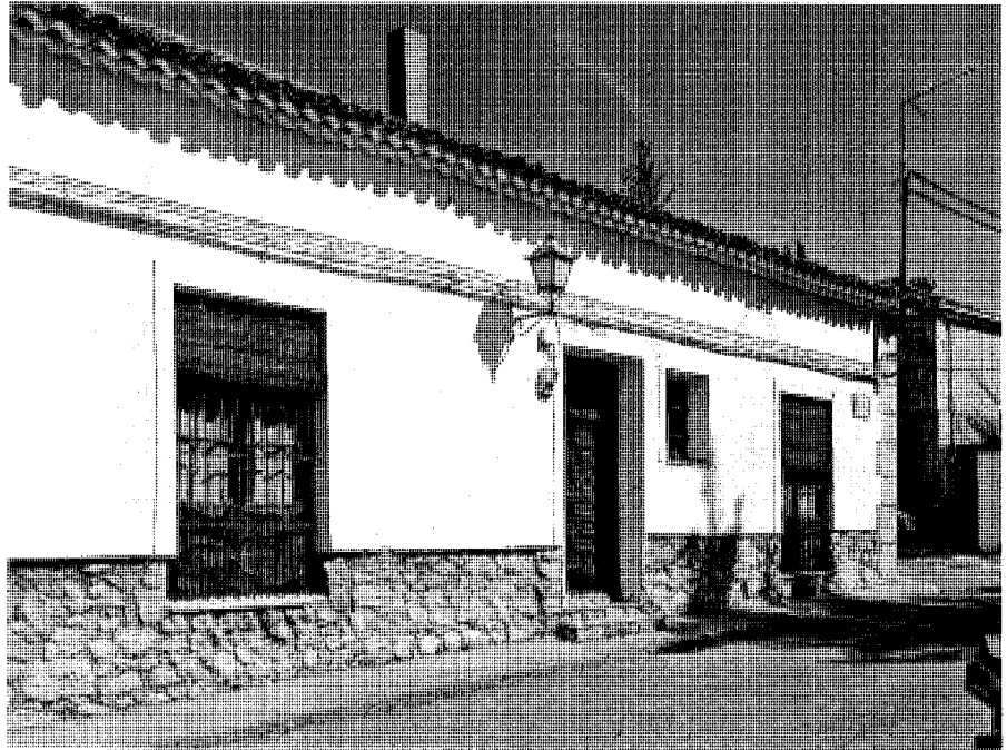
Vivienda en la calle Magistrado Benito Torres 2.
