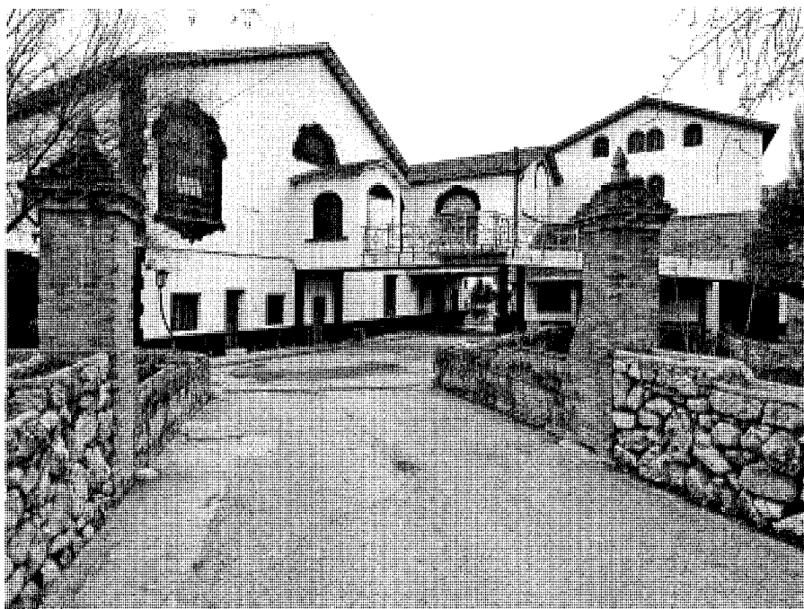
Rampa de acceso a la fábrica.
