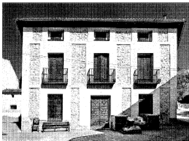
Vivienda en la calle Travesera 7.
