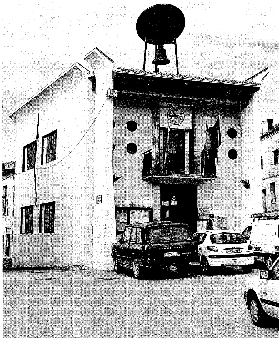
Fachada principal Foto Vicente Patón.
