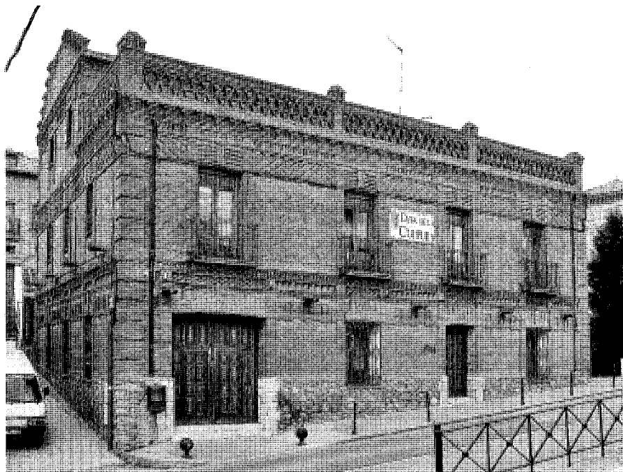
Fachada principal. Foto Vicente Patón.
