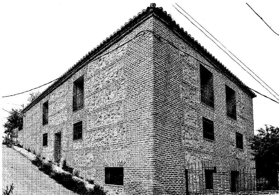
El antiguo pósito pontifical, tras su reciente rehabilitación para uso residencial. Foto Vicente Patón.
