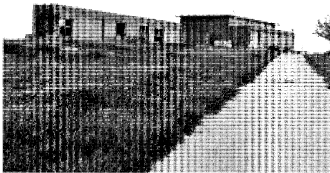
Las instalaciones abandonadas de la Central de Comunicaciones Aeroespaciales. Foto Vicente Patón.
