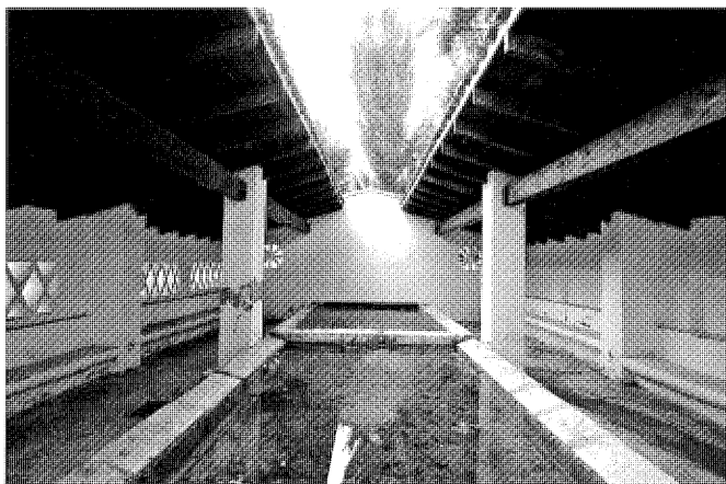
Interior del lavadero.
