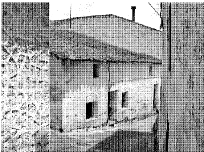
Viviendas en la c/ Fragua, 3 y 5.
