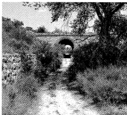
Túnel del Quemado 2. Foto Enrique Krahe.
