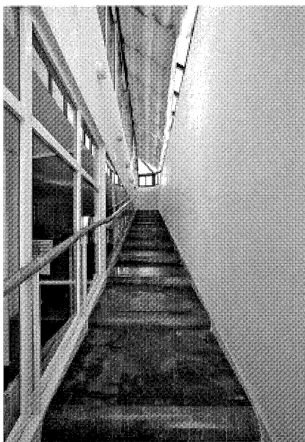
Escalera de acceso a primera planta.
