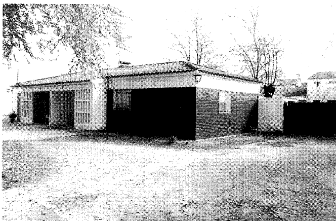
Pareados bajos en la primera extensión del Cortijo. Foto Vicente Patón.
