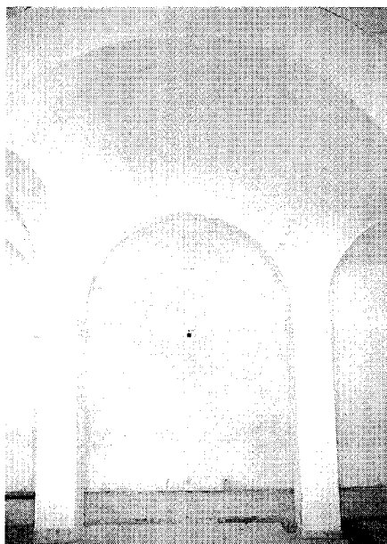
Interior de la Bodega restaurado por la arquitecta Mercedes Álvarez García, detalle de bóveda baída. Foto Alberto Tellería.
