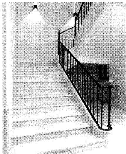
Escalera después de la rehabilitación. Foto OHL.
