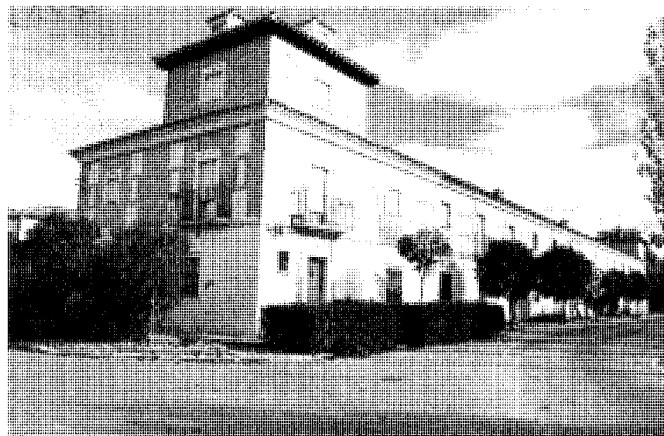
Bloque de adosados simétrico a la Casa Grande. Foto Vicente Patón.
