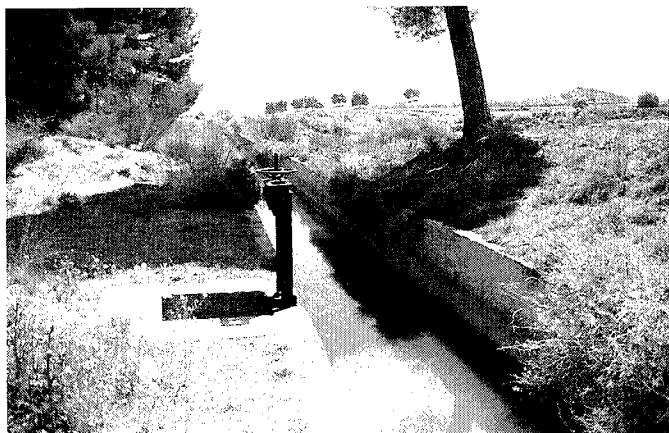
La acequia de Villamejor.
