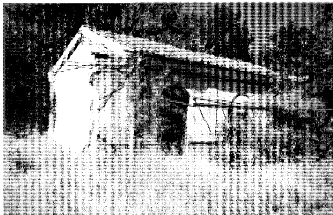
Supervivencia en ruinas del primitivo Embarcadero de Aranjuez. Foto: Vicente Patón Jiménez, 2001.
