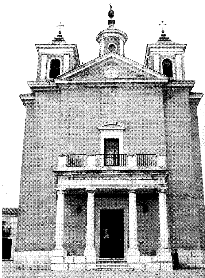
Fachada principal. Foto Vicente Patón.
