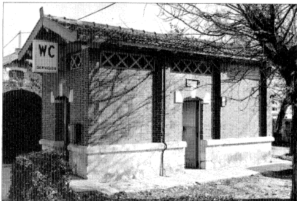
Estación. Edificio auxiliar.
