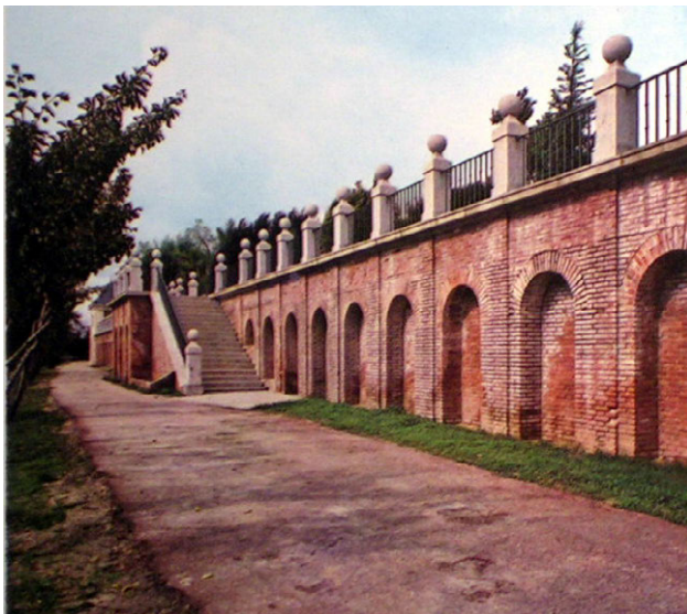
Vista del muro de contención y escaleras. MARQUESA DE CASA VALDÉS, 1987
