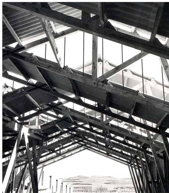
Corrales y Molezún. Instituto en Herrera de Pisuerga, 1956. Fotografía de la cubierta del gimnasio en obra Fotografía publicada en BAU 7, abril 1993
