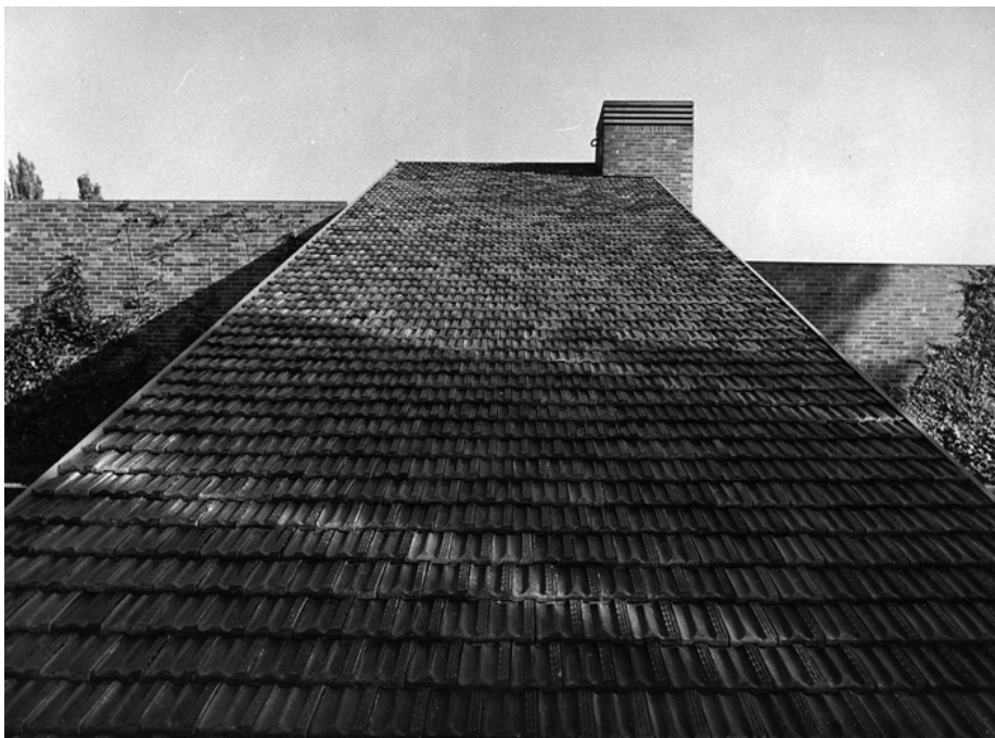
Figura 16. Casa Huarte. Faldón de cubierta ascendente. Fotografía: Legado Vázquez Molezún. Fundación COAM
