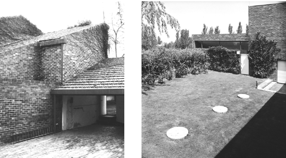
Figura 19. Izquierda: Garaje desde el patio de entrada. Al fondo tras la puerta se puede ver el patio de dormitorios. Fotografía: Pablo Olalquiaga. Derecha: Fachada del garaje hacia el patio de dormitorios. Fotografía: Legado Vázquez Molezún
