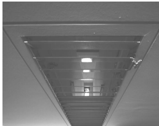
Figura 33. Ventana lucernario. Visita de la ventana a la fachada sur a través de las lamas tipo graven enrasadas con el falso techo. Fotografía: Pablo Olalquiaga
