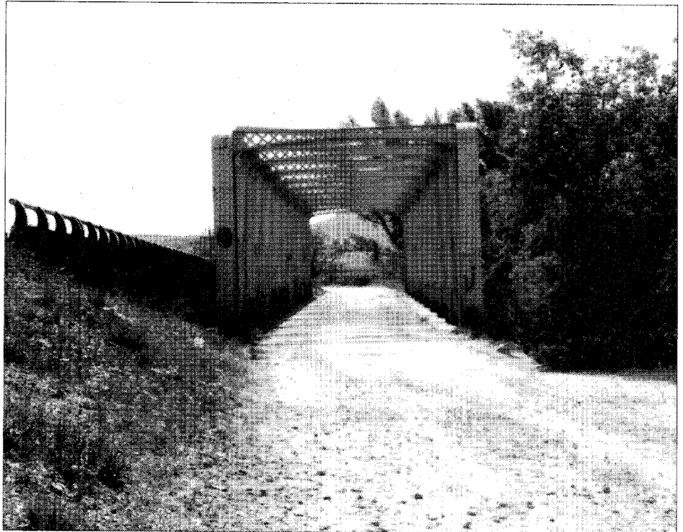
Vista del tablero.
