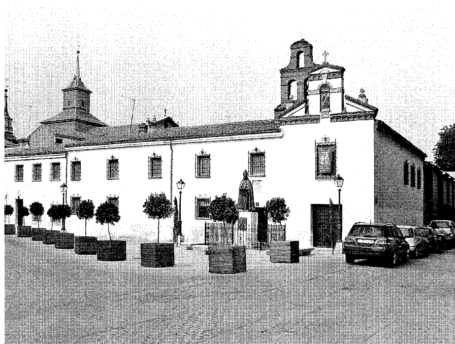
Convento de Clarisas de San Diego. Fachada principal. Foto Pilar Martín-Serrano.
