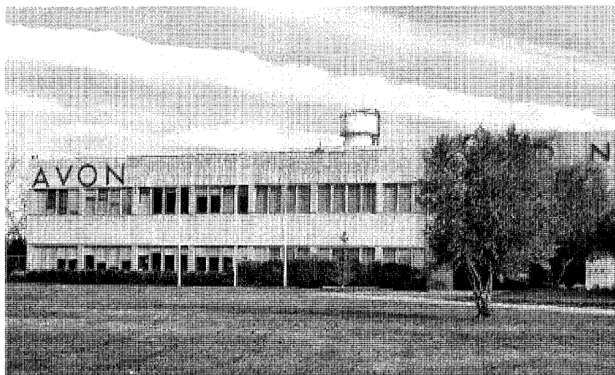
Fabrica Avon. Una de las primeras industrias que se establecieron en el municipio en la primera mitad del siglo XX. Foto Pilar Martín-Serrano.
