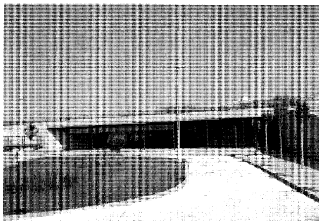
Estación depuradora de aguas residuales. Carretera M-305. Foto Miguel Ángel Vega Delgado.
