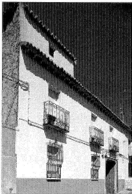
Vivienda y bodega en la calle de los Clérigos, 45. Vista exterior. Foto Actividades y Servicios Fotográficos, S.A.
