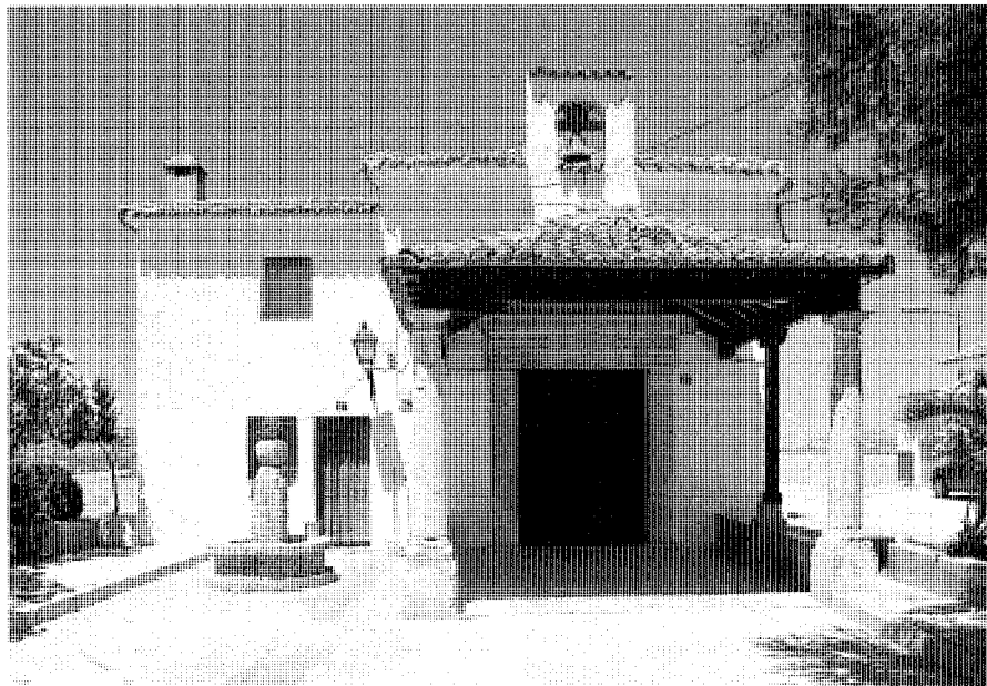
Pórtico delantero. Foto Actividades y Servicios Fotográficos, S.A.
