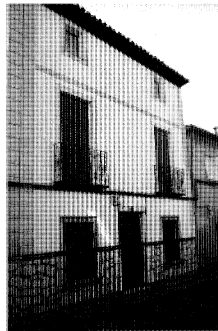
Vivienda en la calle de las Eras, 10. Foto Miguel Ángel Vega Delgado.
