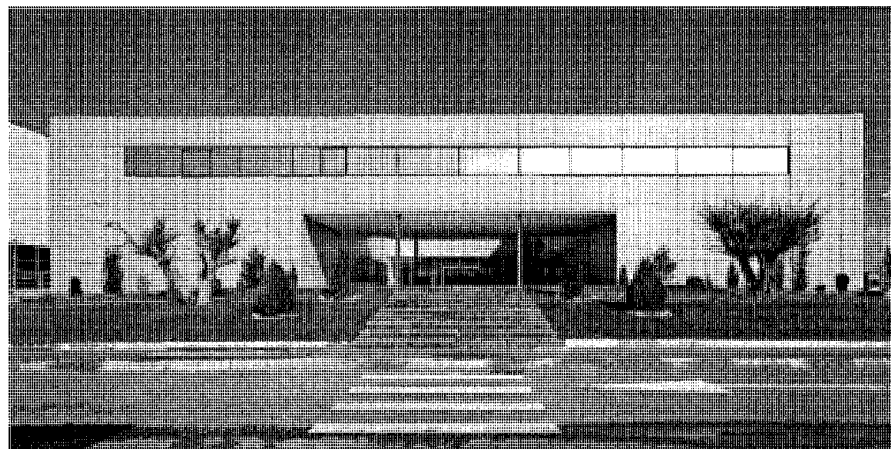
Fachada principal. Fotografía cedida por los autores.
