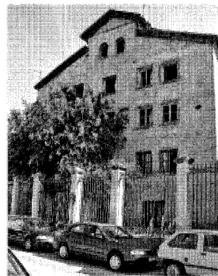
Vista del edificio destinado a prisión. Foto José Ablanedo.
