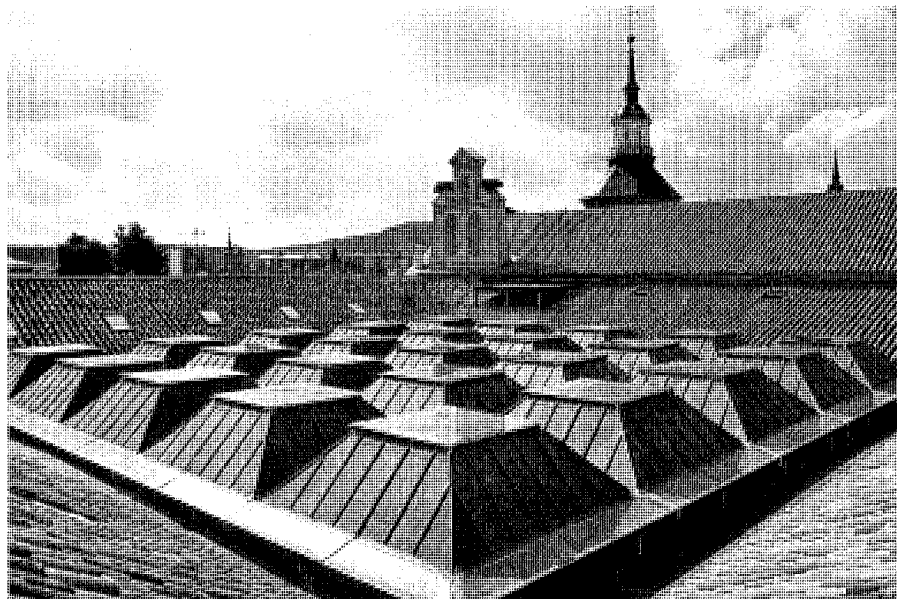
Cubierta del claustro. Fotografía cedida por el autor de la restauración.
