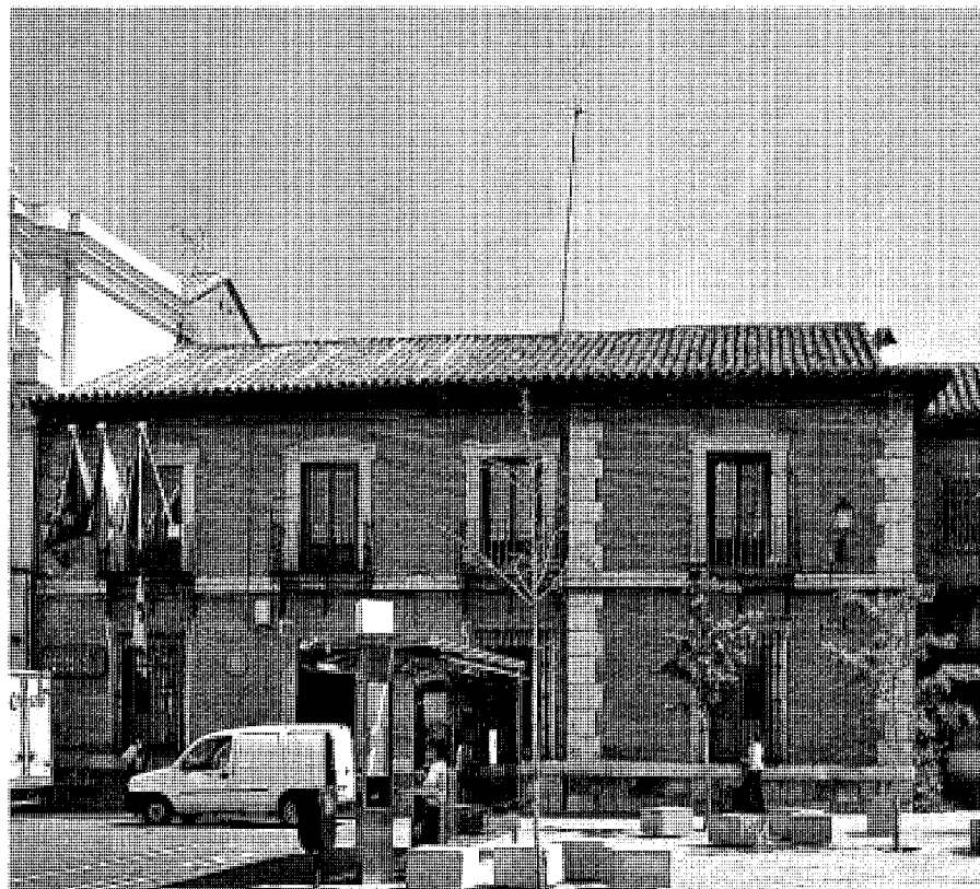
Fachada. Foto José Ablanedo.
