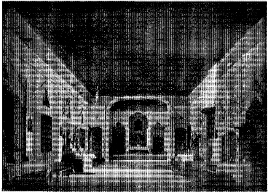
Vista de la nave en 1914. Fotografía tomada de La Esfera .
