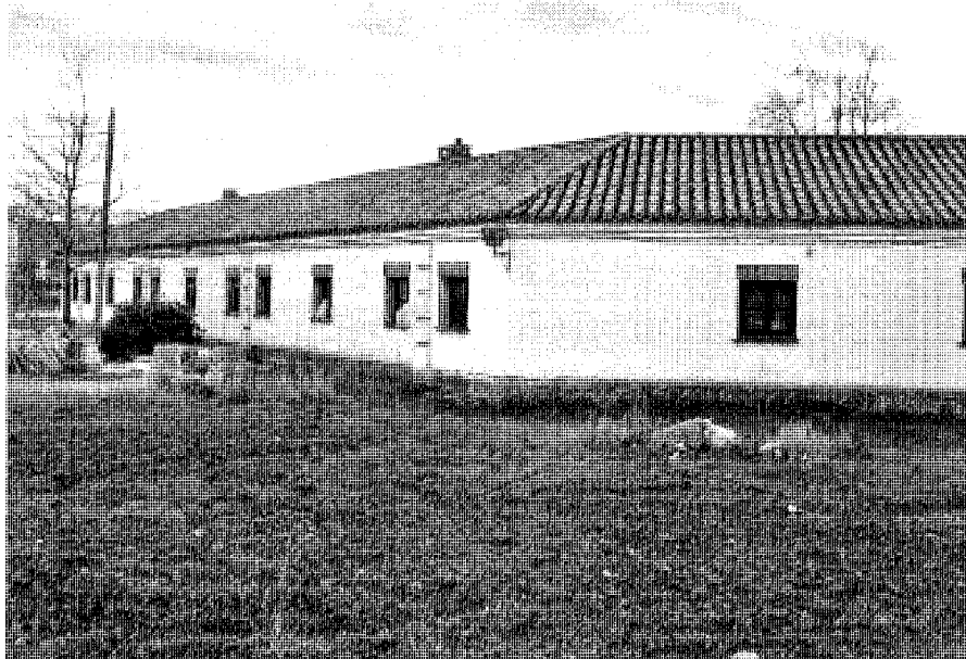
Fachada exterior. Foto Pilar Martín-Serrano.
