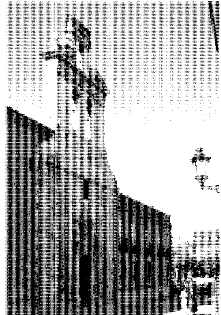
Fachada. Foto José Ablanedo.
