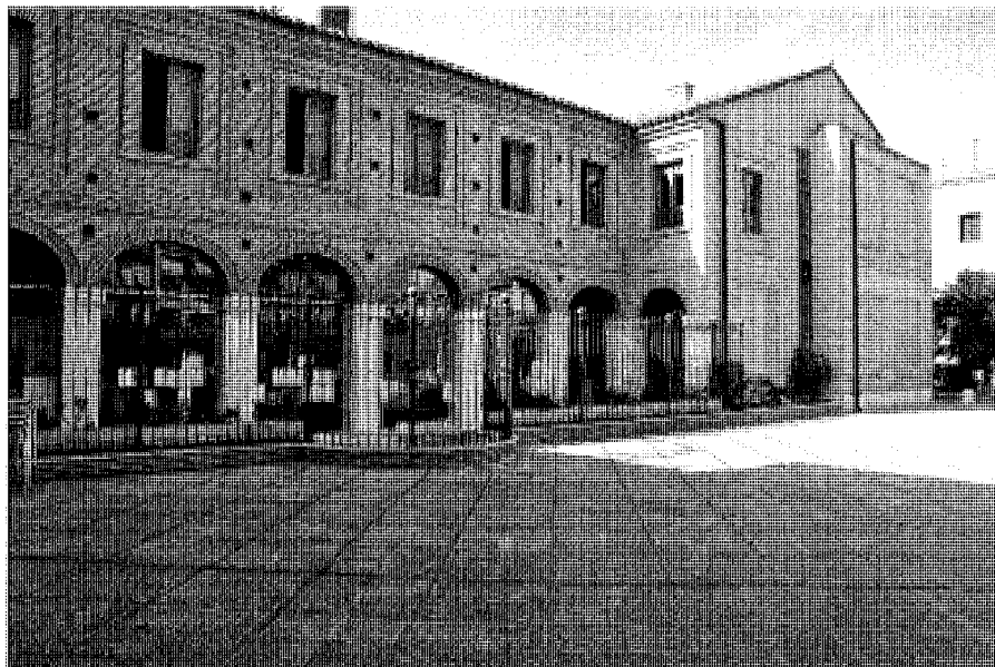
Restos del Claustro. Foto José Ablanedo.
