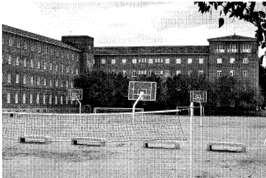
Patio y zona posterior. Foto Pilar Martín-Serrano.
