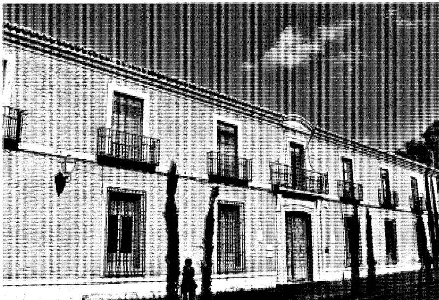
Fachada principal. Foto Pilar Martín-Serrano.
