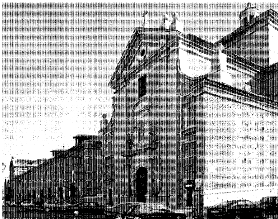
Vista general del edificio. Fotografía del autor de la restauración.
