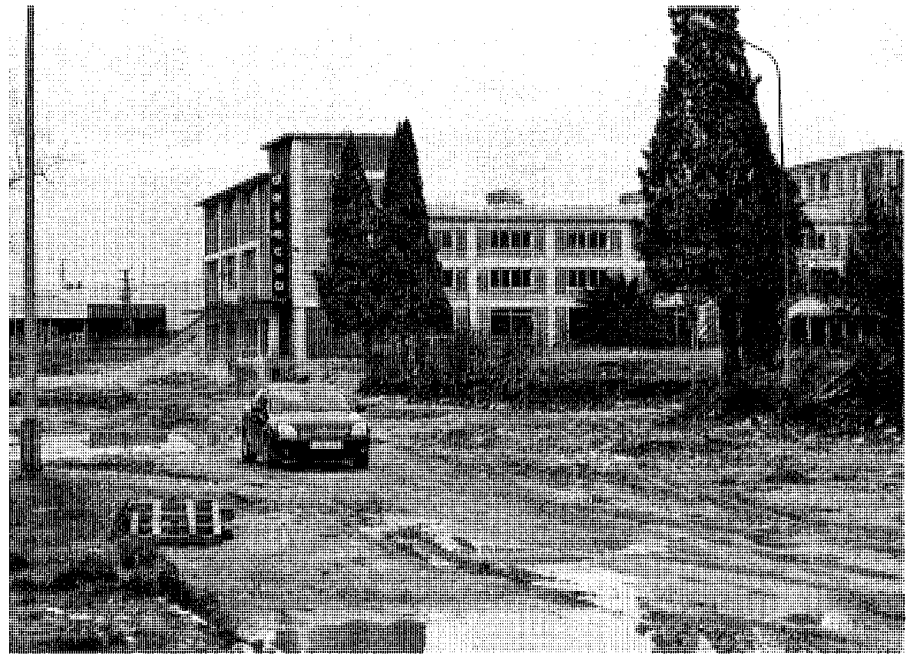
La fábrica en el momento de la demolición de parte del edificio. Foto Pilar Martín-Serrano.
