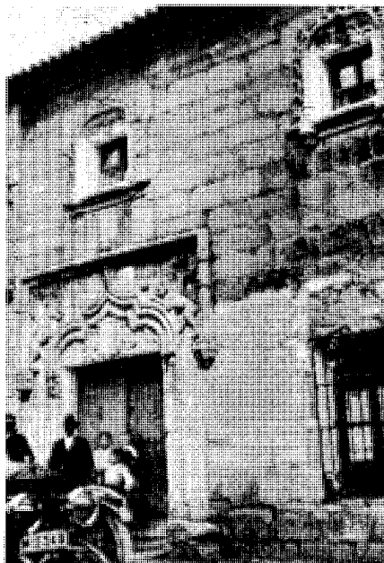
Fachada de la Casa del Cura. Arquitectura civil española de los siglos I al XVIII.
