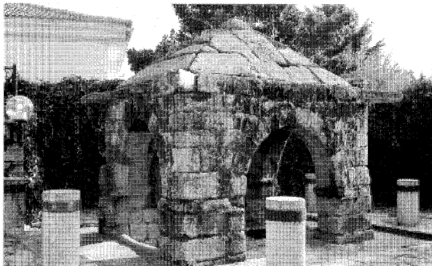
Fuente de los Álamos. Fot. Actividades y Servicios Fotográficos, S.A.
