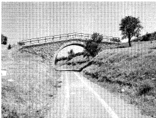
Vista de la Via Verde del Tajuña sobre el antiguo trazado del ferrocarril y un puente original. Foto Fundación Arquitectura COAM.
