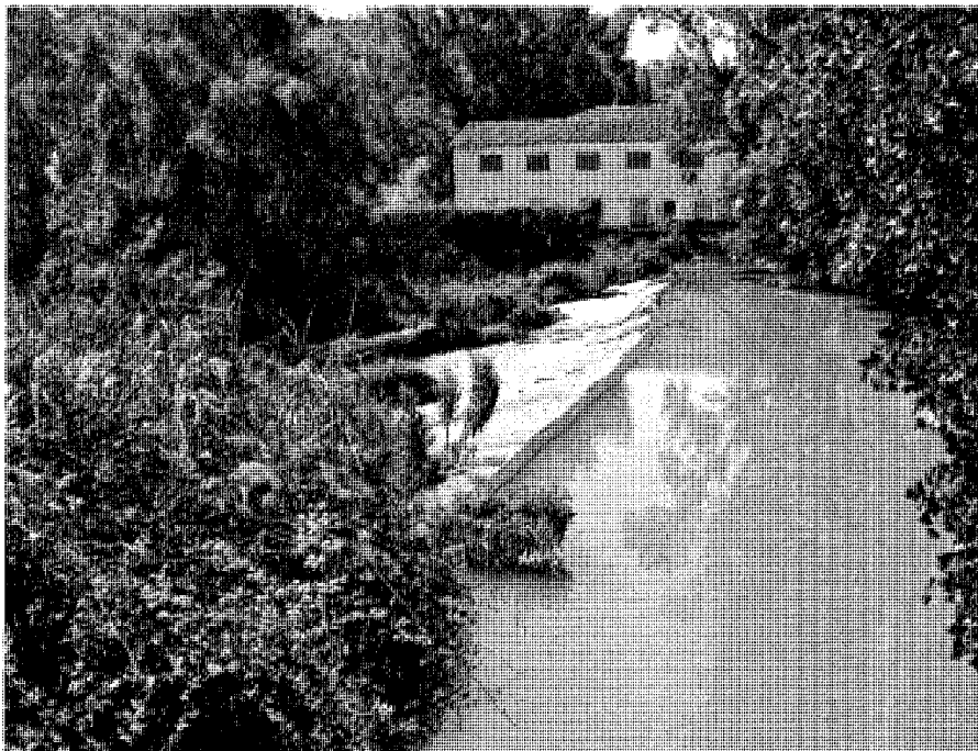
Vista de la represa del Tajuña. Foto Fundación Arquitectura COAM.
