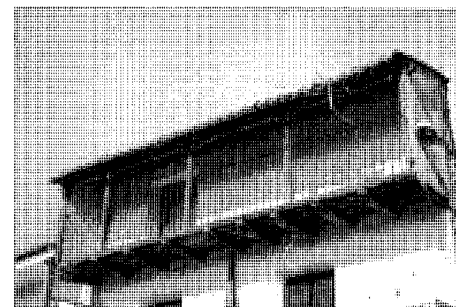
Detalle Corredor. Avenida del Generalísimo
