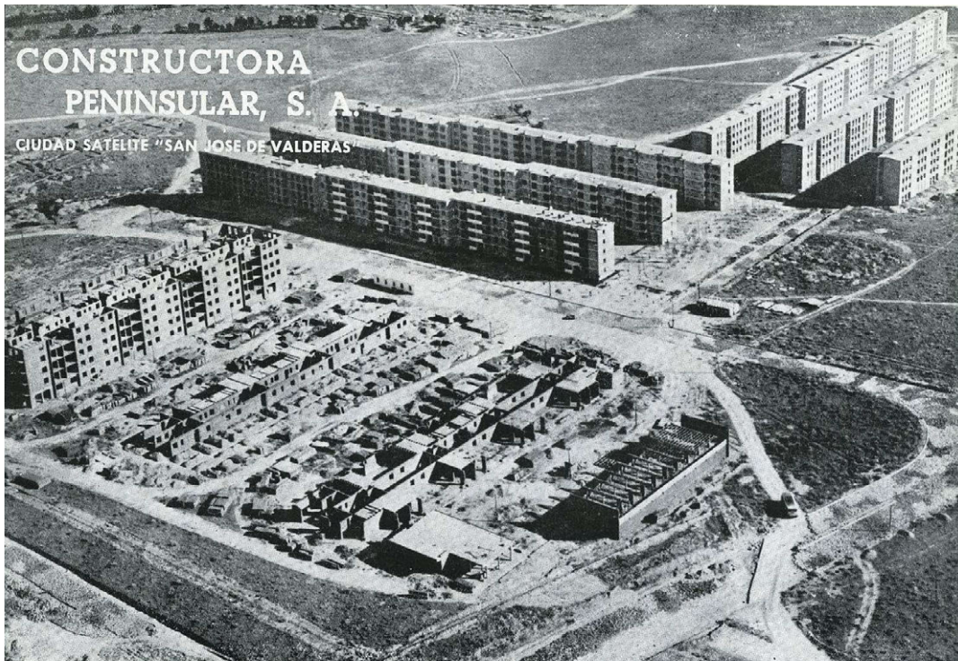
Figura 4.48: Foto aérea de San José de Valderas en construcción, "ciudad satélite" de la corona de Madrid Fuente: Revista Hogar y Arquitectura 1959, Número 24-25.
