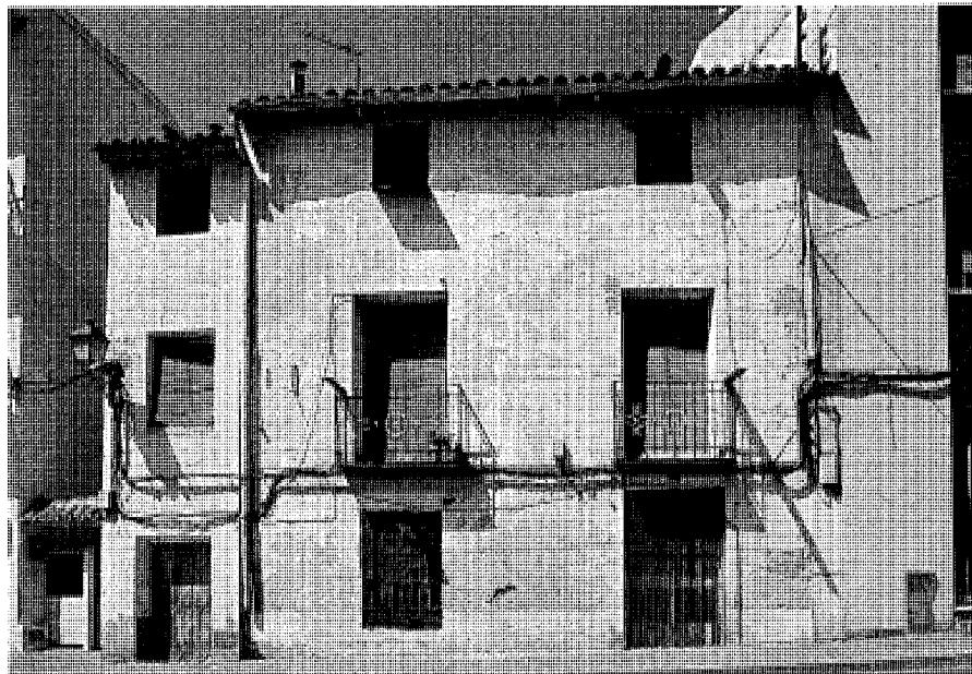
Vivienda en calle Mayor Alta, 131.
