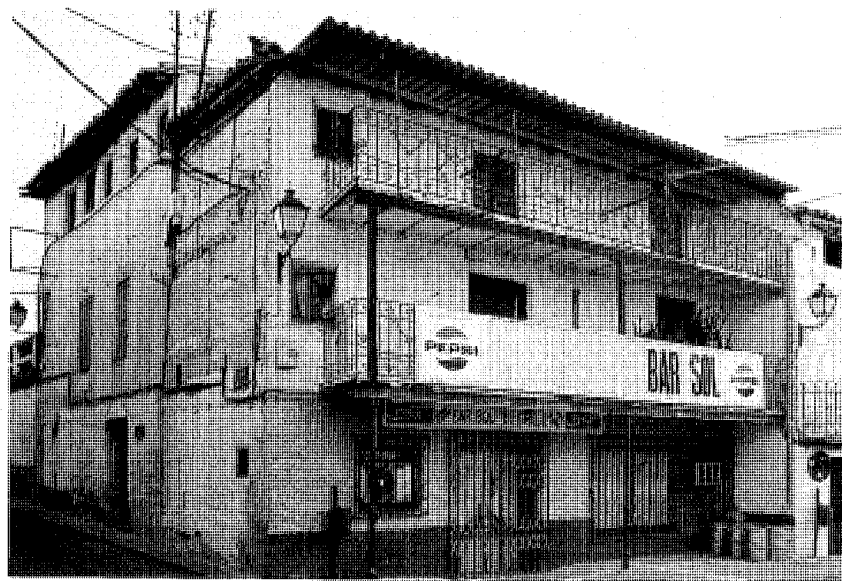
Vivienda en plaza de la Constitución, 7.
