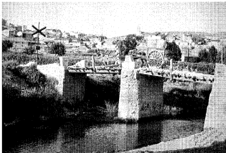
Vista antigua del puente a la fábrica de papel. Foto M. González.
