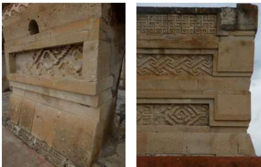
Detalles de la tectónica de los muros, de los palacios del Conjunto de las Columnas de Mitla. En la foto de la derecha, podemos observar el sistema constructivo de “tablero doble” con grecas de piedras integradas al muro, sistema típico de Mitla.
