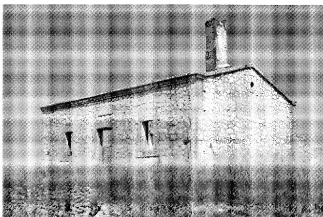
Casa de peones camineros en la carretera M-222.
