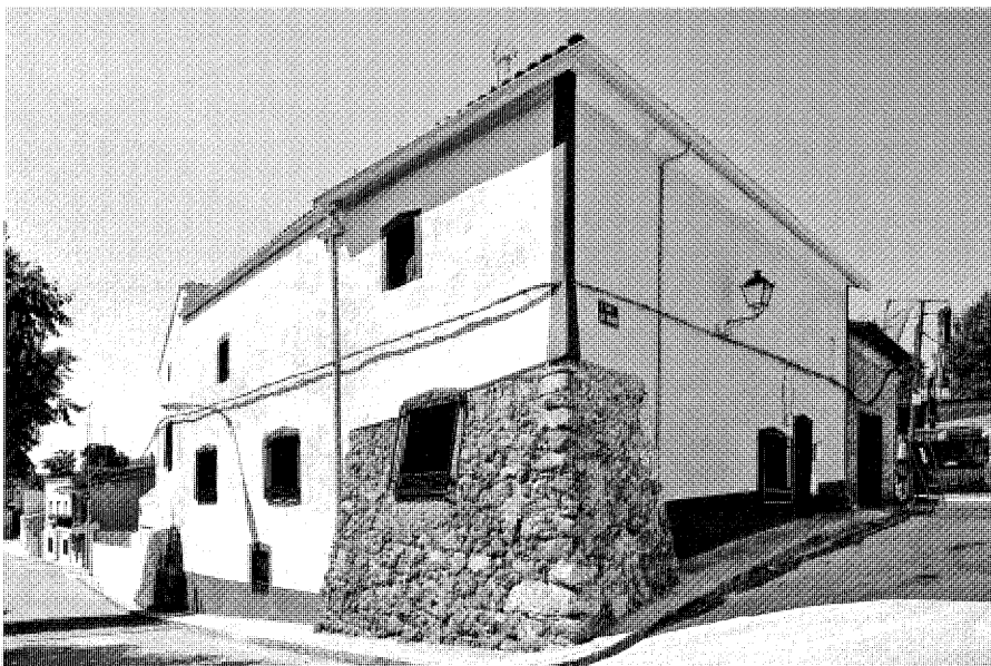
Calle Tercia c/v calle de la Fuente.
