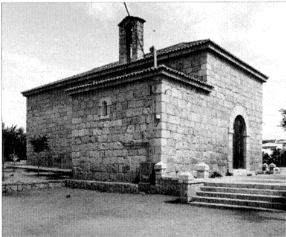
Vista del acceso.
