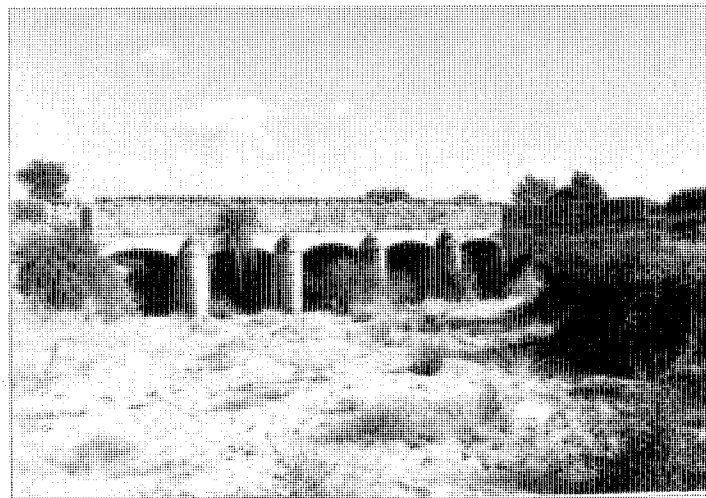
Puente de servicio de las cañas de la Parrilla.
