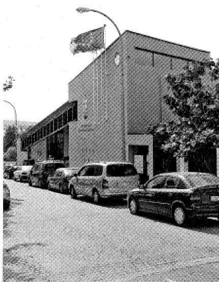
Vista de conjunto desde la encrucijada entre las calles Alcalá y Carlos Martín Álvarez. Foto, Jose Ablanedo, 2007.
