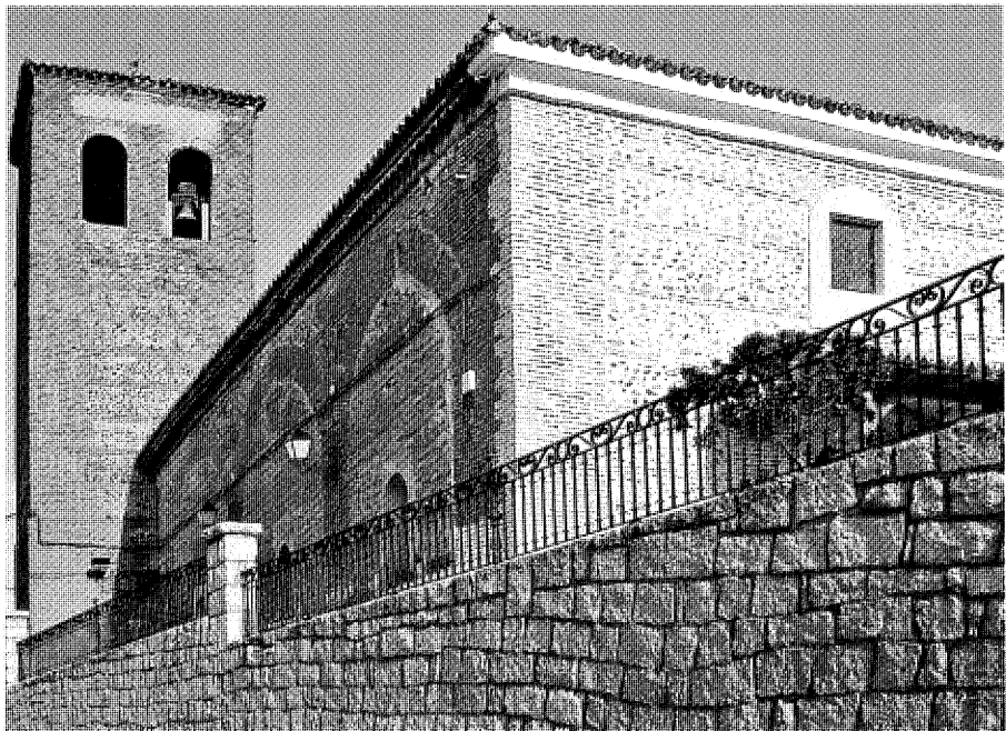
Vista lateral de la fachada del Evangelio con la torre al fondo. Foto, Félix Cabrero, 2005.
