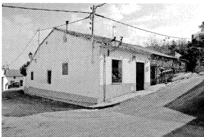
Casa rural revocada en la calle Fragua, 13 y 15 c/v Juan Carlos I. Foto, Jose Ablanedo, 2007.
