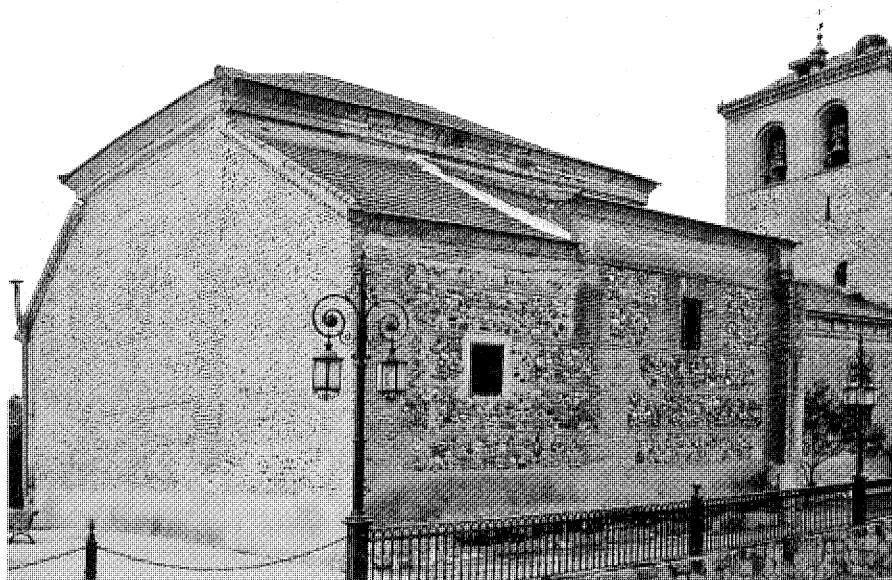
Vista general desde la cabecera de la fachada del Evangelio, con la torre a los pies. Foto, Félix Cabrero, 2005.
