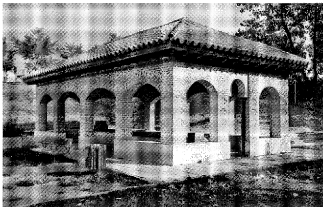
Lavadero reconstruido en Valdeolmos por la Escuela Taller Dehesa Paeque de Alalpardo. Foto, Jose Ablanado, 2007.
