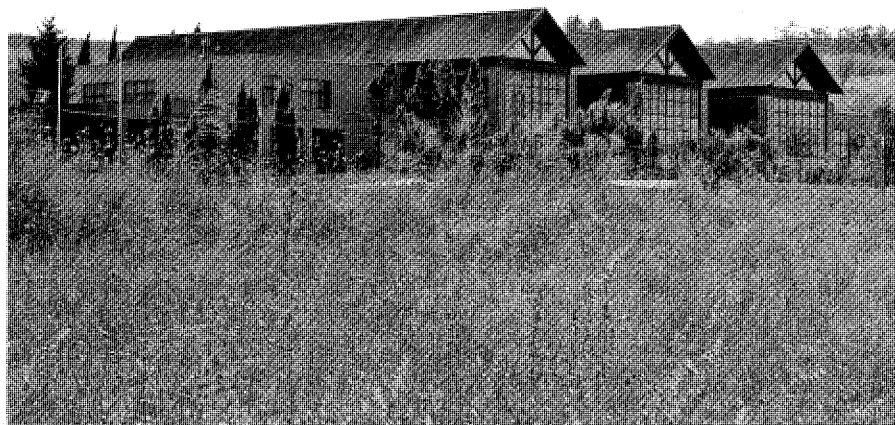
Vista panorámica. Jose Ablanedo, 2007.
