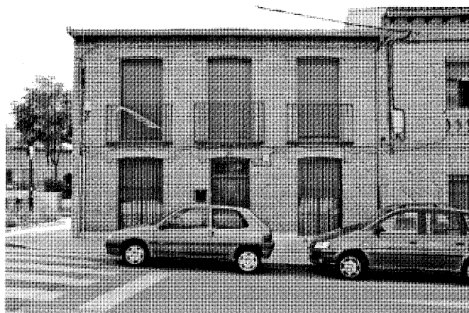
Vivienda urbana en ladrillo en la calle Carlos Martín Álvarez, 10. Foto, Jose Ablanado, 2007.
