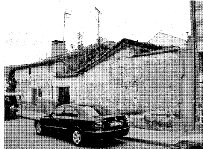
Vivienda popular de adobe revocado en la calle Calvo Sotelo, 5 c/v Generalísimo. Foto, Félix Cabrero, 2005.
