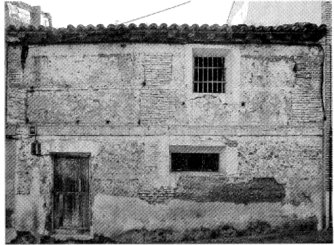
Tapial, ladrillo y piedra en canto rodado, materiales utilizados en la construcción de las casas. Dos ejemplos en el cerramiento de parcela de la calle de la Fuente y en la calle General Mola, 3, de Alalardo. Fotos, Jose Ablanado, 2007 y Félix Cabrero, 2005.
