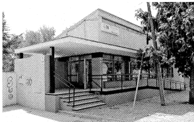
Consultorio de Alalpardo. Detalle de la fachada a la carretera. Foto, Jose Ablanedo, 2007.
