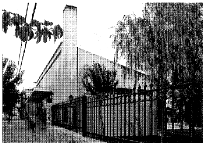
Consultorio de Alalpardo. Fachadas principal y lateral. Foto, Félix Cabrero, 2005.
