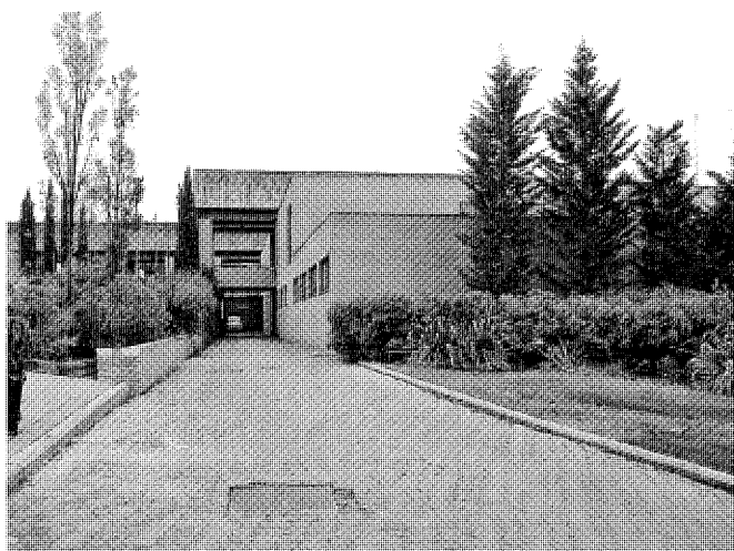
Fachada de acceso. Félix Cabrero, 2005.
