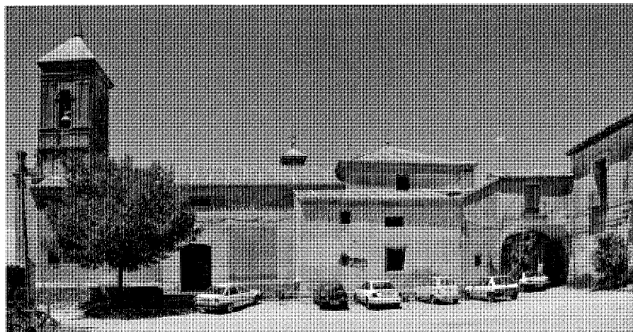
Fachada meridional. Foto Vicente Patón.
