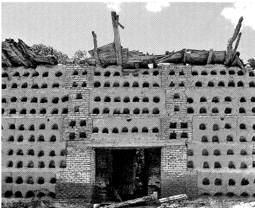
Detalle del patio occidental hacia la puerta de entrada. Foto Vicente Patón.
