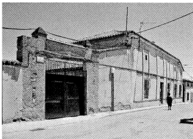
Vivienda en la calle de las Rosas, nº 34. Foto Vicente Patón.
