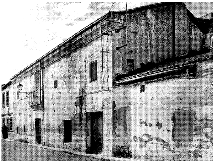
Vivienda en la calle de la Ronda, nº 105. Foto Vicente Patón.
