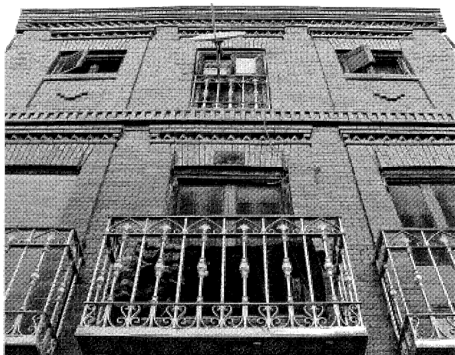
Vivienda en la calle de Sevilla, nº 7. Foto Vicente Patón.
