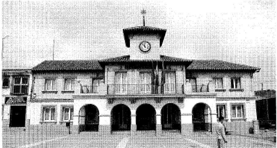
Fachada Principal. Foto: Jose Ablanedo
