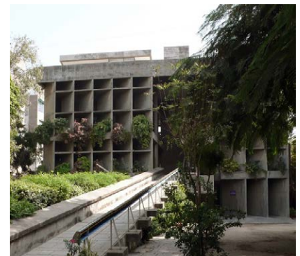
Fig.2.4.16 Palacio de los Hilanderos . Ahmedabad, India. 1954. Le Corbusier.
