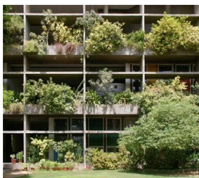
Fig.4.53 Palacio de los Hilanderos . Ahmedabad, India. 1954. Le Corbusier
