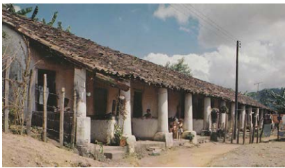
Fig.3.1.8 Azucarera Matas. Cabo de Santo Agostinho, Pernambuco. Edificio de viviendas para esclavos
