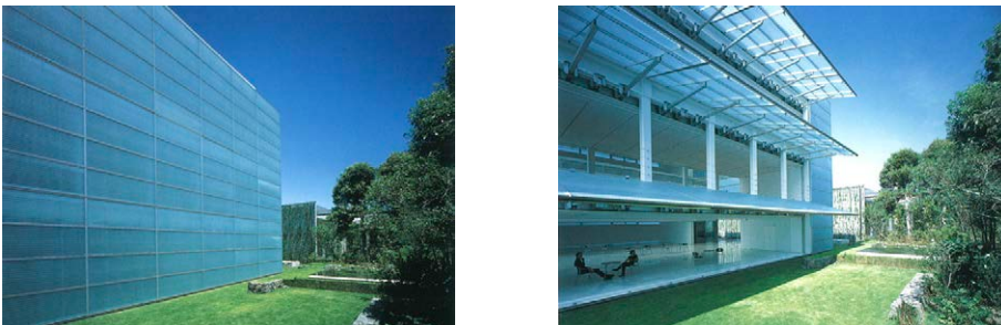
Fig.6.3.9 Paper Art Museum . Shizuoka. 2002. Fachada lateral en posición abierta y cerrada
