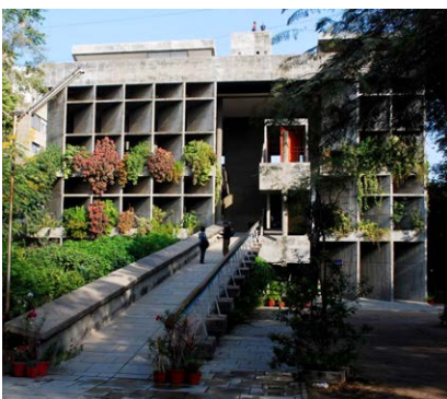
Fig.4.52 Palacio de los Hilanderos . Ahmedabad, India. 1954. Le Corbusier
