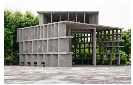
Fig.2.2.11 Torre de las Sombras . Chandigarh. 1956 Le Corbusier
