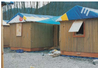
Fig.6.3.1 Paper Log Houses. Nagara, Kobe, Japón. 1995 Kaynasli, Turquía. 2000 Bhuj, India. 2001
