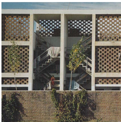
Fig.3.3.9 Vivienda tipo 10-JB Chandigarh, 1956 Pierre Jeanneret
