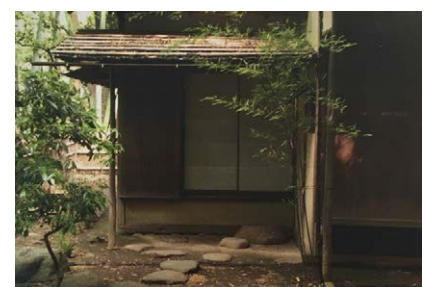
Fig.3.1.4 Dobisashi de acceso a casa de té Shunsōro, parque Sankei-en, Yokohama
