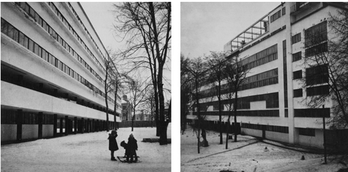
Fig. 23. Edificio Narkomfin. Fachadas delantera y posterior en 1930.
