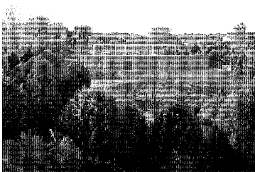
Vista general de la vivienda en su entorno. Foto cedida por el autor.
