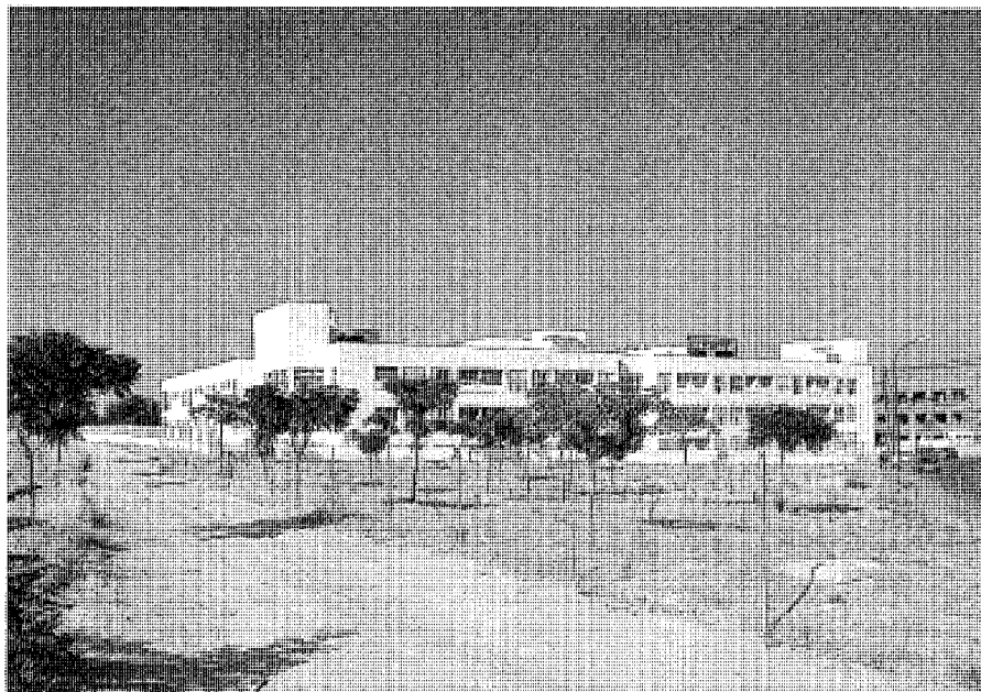
Vista general del edificio. Jose Ablanedo, 2000
