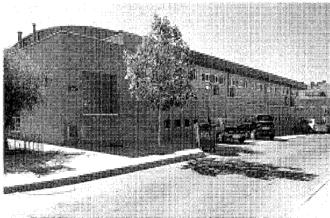
Polideportivo cubierto. Jose Ablanedo, 2000.
