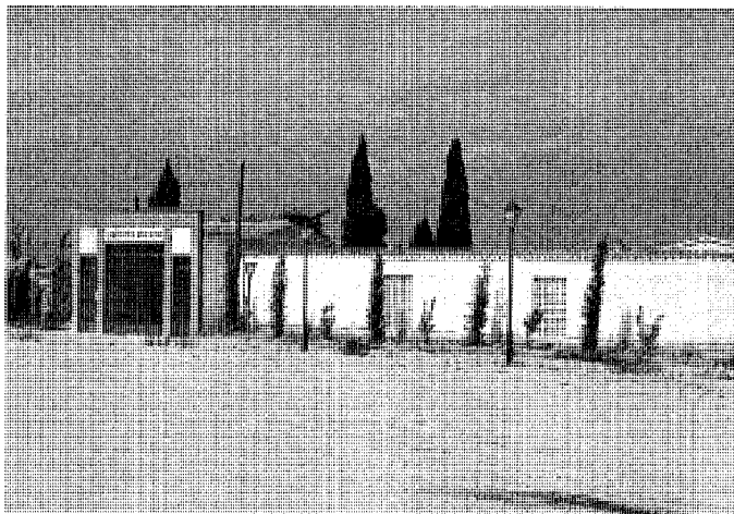
Cementerio Municipal. Foto José Ablanedo.
