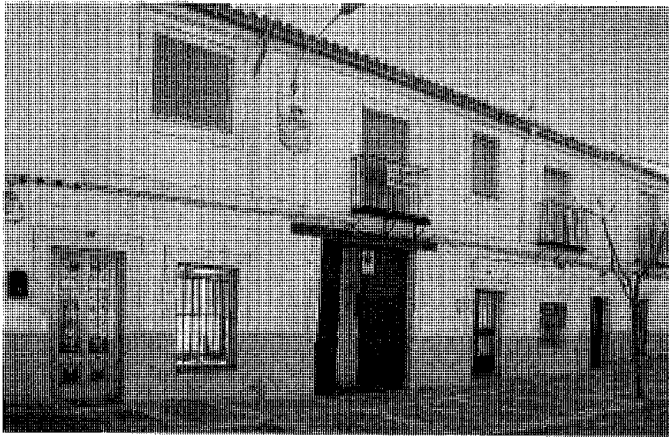
Casa en la calle Constitución, 118, 120 y 122.
