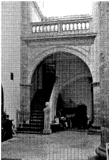
Escalera de acceso a la tribuna. Foto José Ablanedo.
