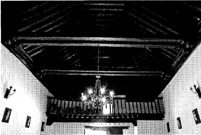
Armadura de cubierta. Foto José Ablanedo.
