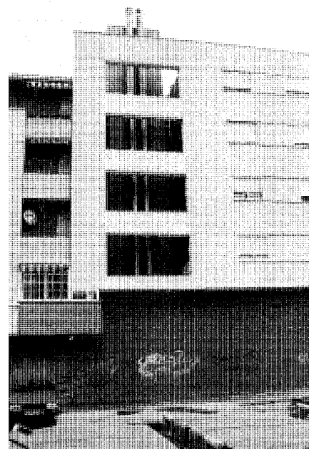
Detalle de la fachada a C/ Reyes Católicos. Foto Pilar Lorenzo
