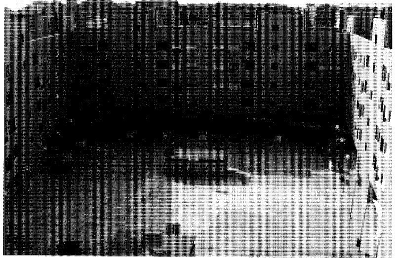
Vista del patio interior. Foto del autor.
