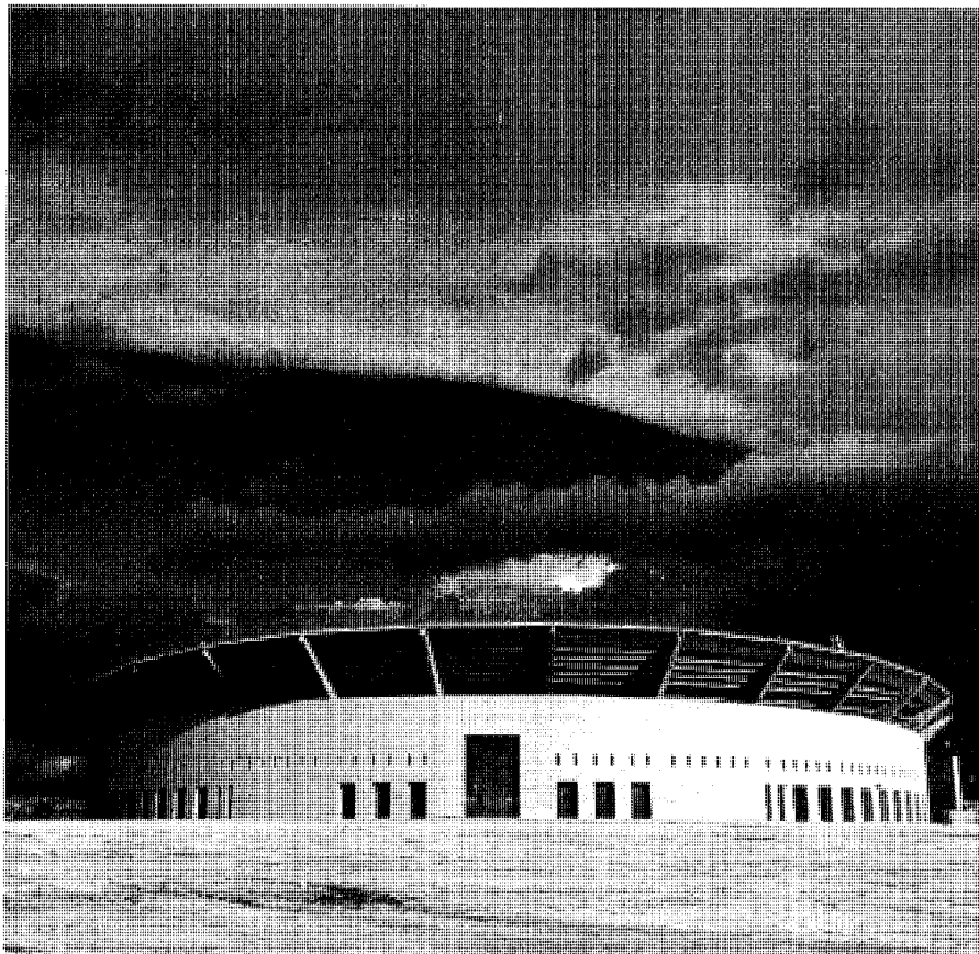
Fachada sur. Foto del autor.
