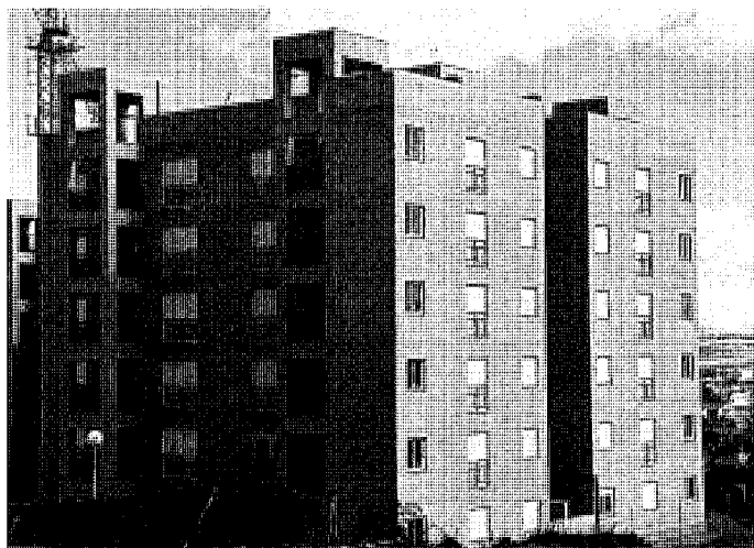
Bloque de viviendas en Parque Coimbra. Foto Pilar Martín-Serrano.
