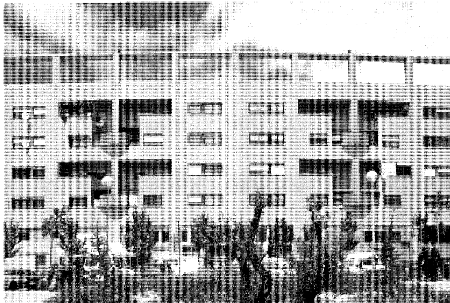
Vista de uno de los bloques. Foto del autor.
