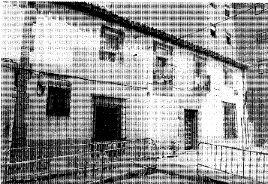
Vivienda en la calle Fausto Fraile 2. Foto José Ablanedo.
