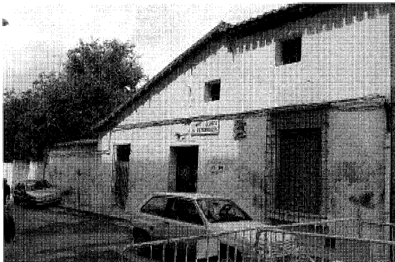
Vivienda en la calle Fausto Fraile 4. Foto José Ablanedo.
