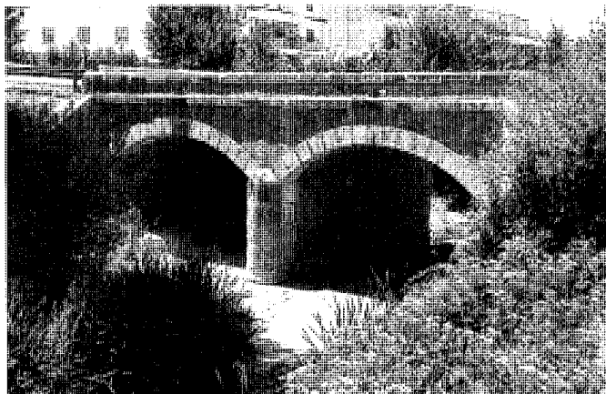
Puente sobre el arroyo de los Combos. Fátima García Lledó, 1998.
