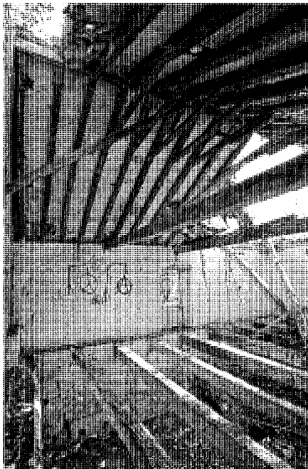
Estructura de la cubierta y del forjado del molino de la Aldehuela.
