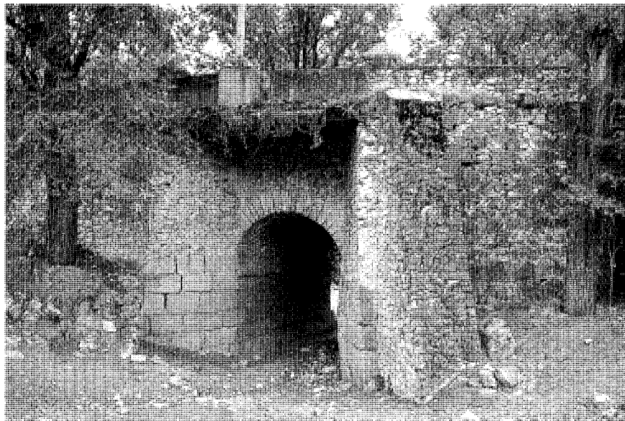
Frente convexo, reforzado con un contrafuerte.
