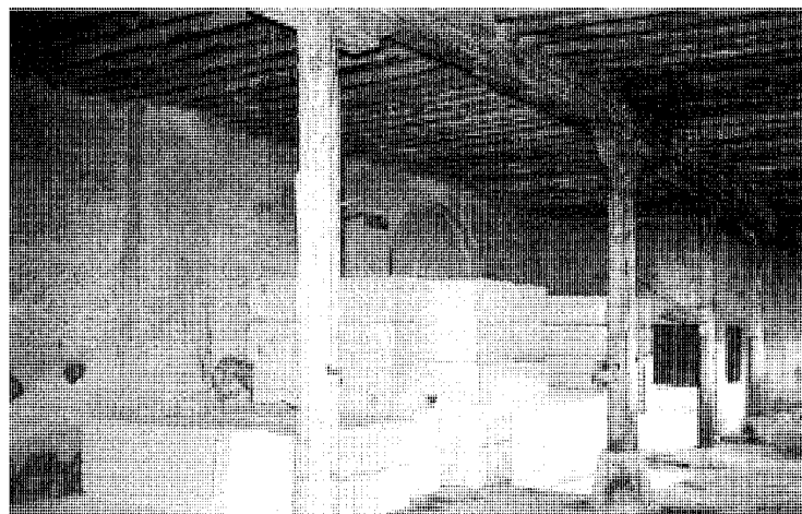
Nave con estructura de pies derechos y forjados de madera.
