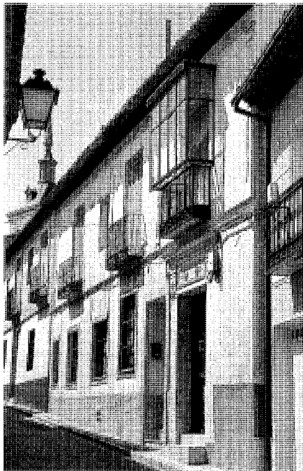
Calle Empedrada, 17. Fachada y patio. Fot. Miguel Ángel Vega.
